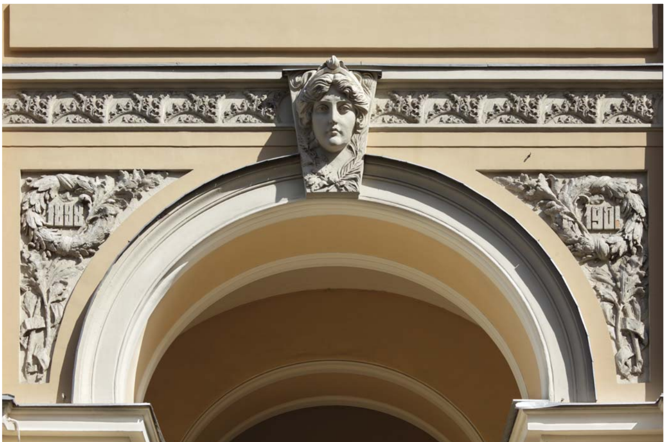
Фрагмент лепного декора над проездной аркой Ботанического института с обозначением даты строительства: 1898-1901
