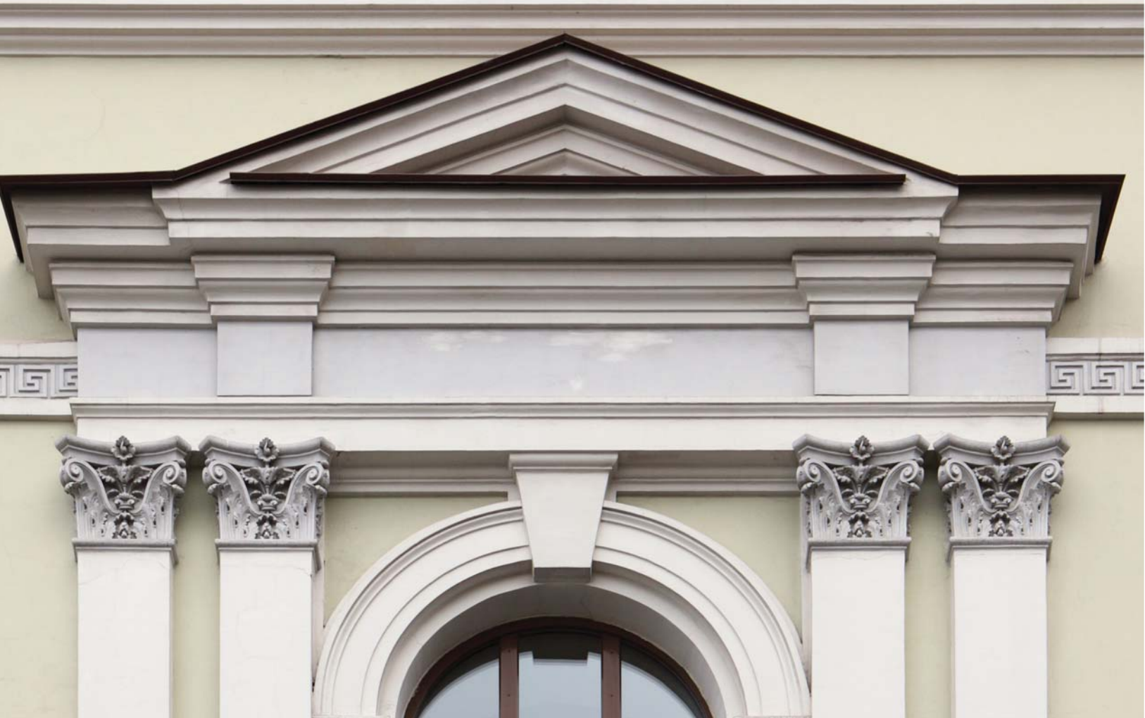
Фрагменты фасада квартирного корпуса Московского университета
