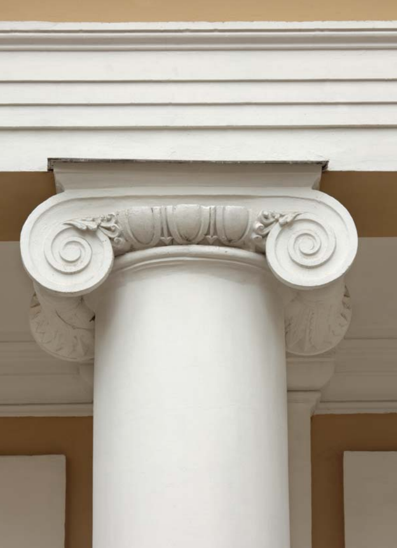
Фрагмент декора главного фасада Терапевтической клиники
