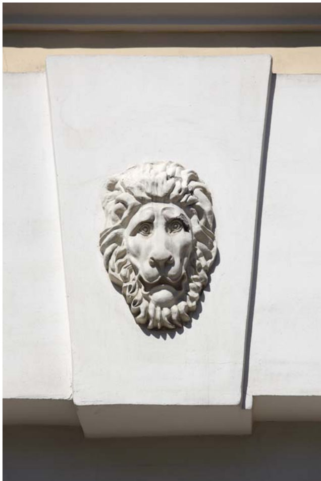
Фрагмент отделки фасада
