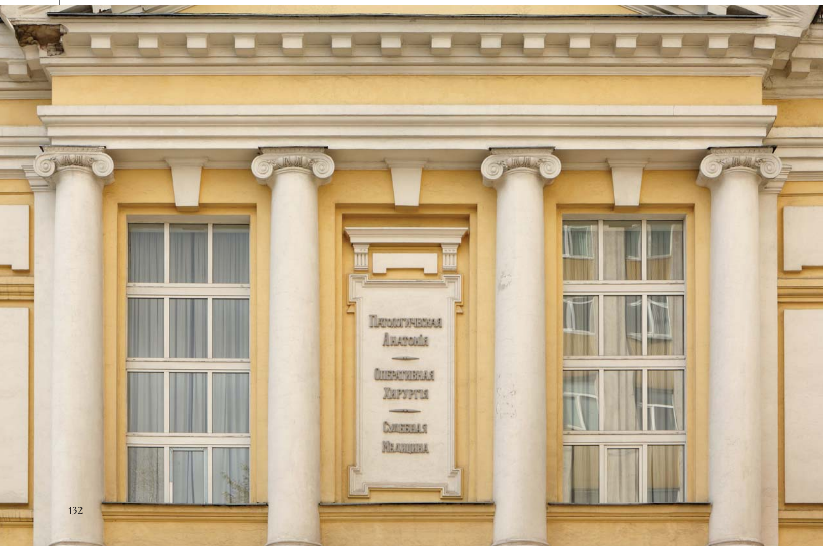
Фрагмент главного фасада Патологоанатомического института
