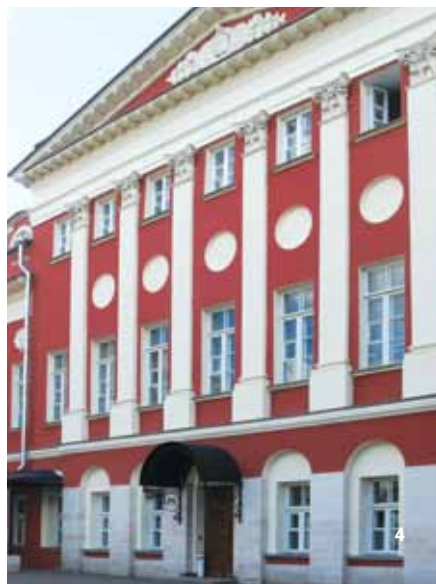
4. Фасад после реставрации 5. Фрагмент фронтона портика главного фасада после реставрации
