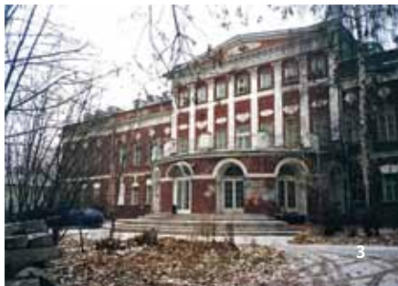
3. Главный дом городской усадьбы в 4-м Сыромятническом переулке. Главный (восточный) фасад до реставрации
