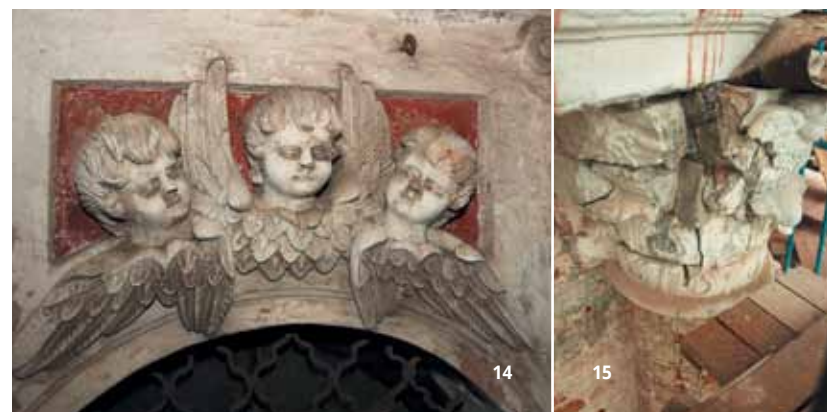
12. Рогожская слобода. Главка Покровского собора 13. Белокаменный цоколь 14. Деталь декора после расчистки 15. Разрушения резных капителей
