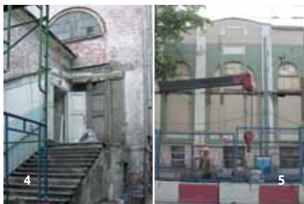
3. Фасад лазарета со стороны храма. Архивное фото 4, 5. Фасад лазарета до реставрации
