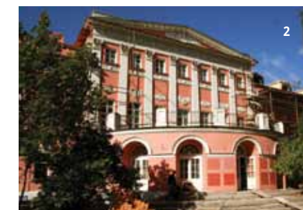
2. Главный дом городской усадьбы в 4-м Сыромятнинском переулке. Фрагмент главного фасада
