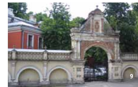
7. Западный фасад Палат Волковых-Юсуповых после реставрации 8. Палаты Волковых-Юсуповых. Ворота после реставрации 9. Палаты Волковых-Юсуповых. Ворота до реставрации 10. Схема южного фасада Палат
