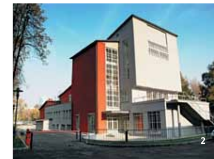
1, 2. Клуб Дорхимзавода с фабрикой-кухней после реставрации
