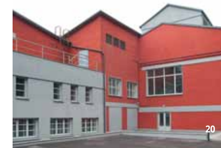
20. Клуб Дорхимзавода с фабрикой-кухней после реставрации
