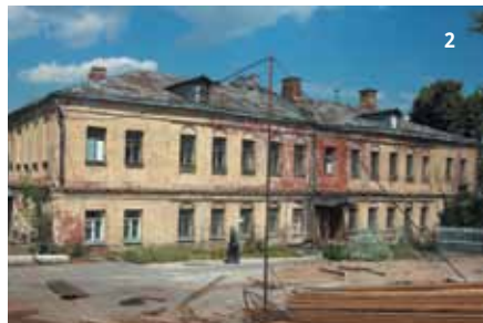
2. Общий вид Зачатьевского сестринского корпуса до реставрации
