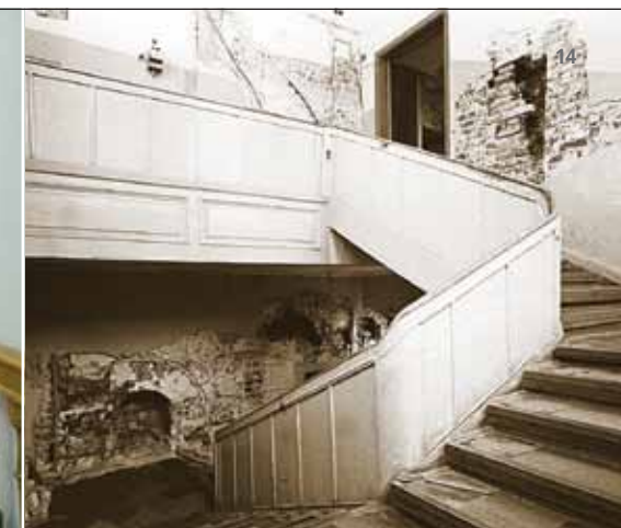
13. Парадная лестница после реставрации. Фотография 1997-го года 14. Парадная дубовая лестница до реставрации. Фотография 1996-го года 15. Территория парадного двора усадьбы Лопухиных. На парадном партере идет строительство городской трансформаторной подстанции. Фотография 1991-го года
