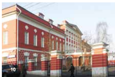
10. Южный фасад после реставрации
