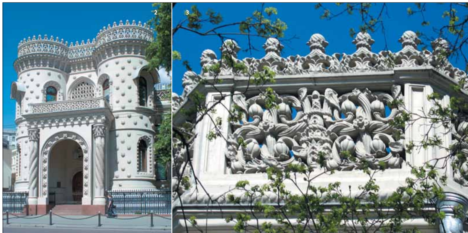
2. Особняк А.А. Морозова. Главный фасад после реставрации 3. Парапет крыши главного фасада
