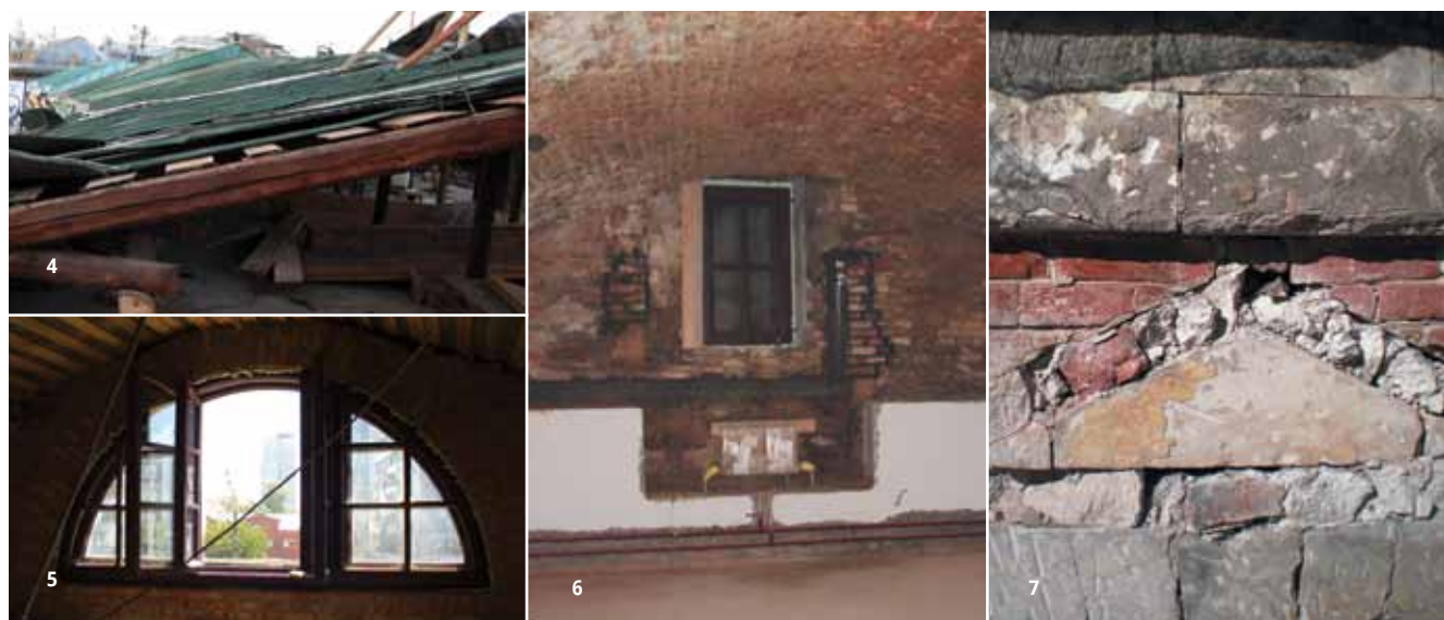
4-7. Доходный дом XIX века на улице Сергея Радонежского, 13 в процессе реставрации
