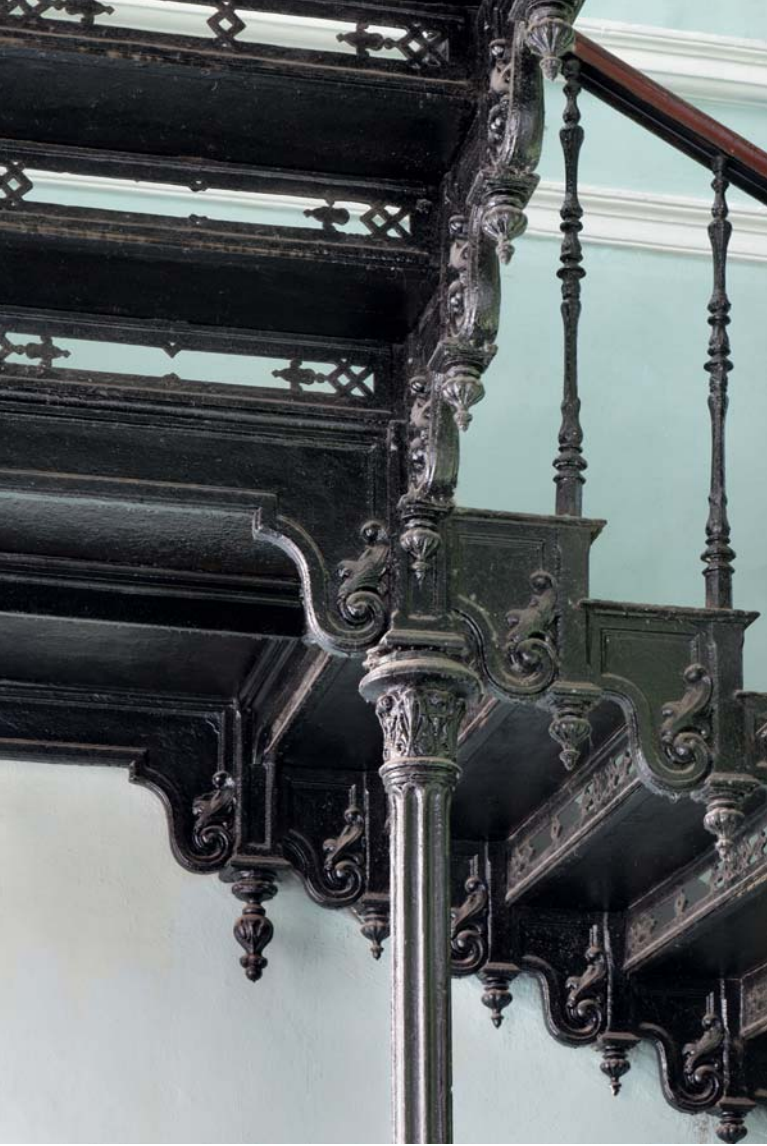
Лестница внутри бывшего Мещанского училища. 1860-е гг.
