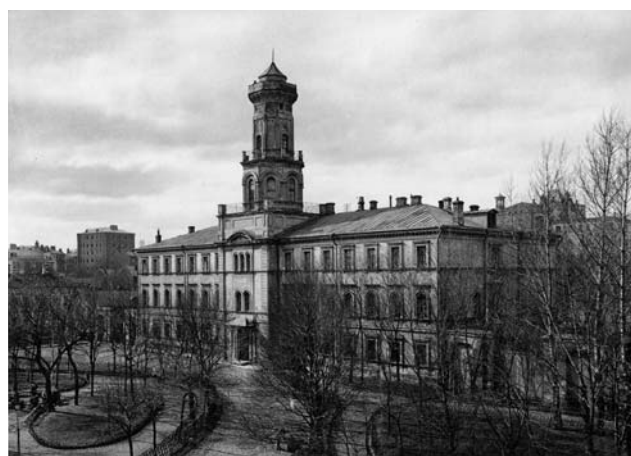
Сущёвский полицейский дом на Селезнёвской ул.
