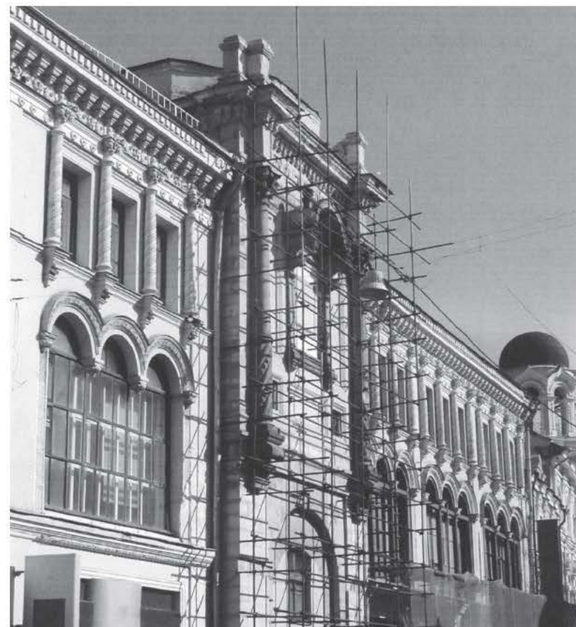
↑ Уличный фасад в процессе реставрации
