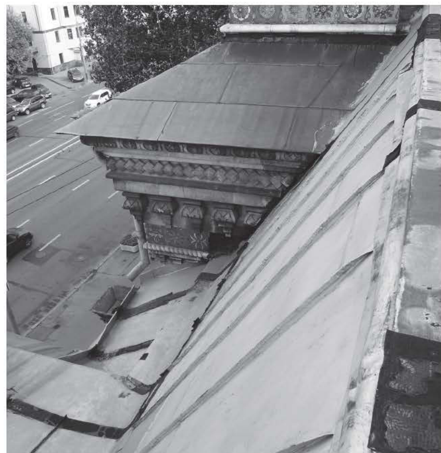
↑ Фрагмент кровли главного дома до реставрации
