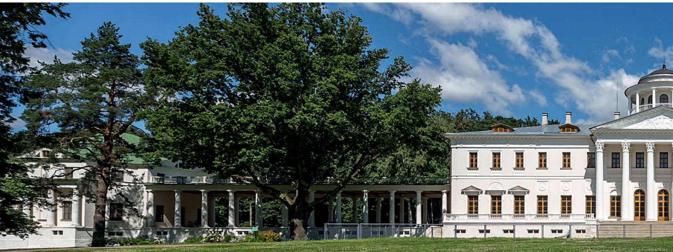
↑ Главный фасад с галереями после реставрации
