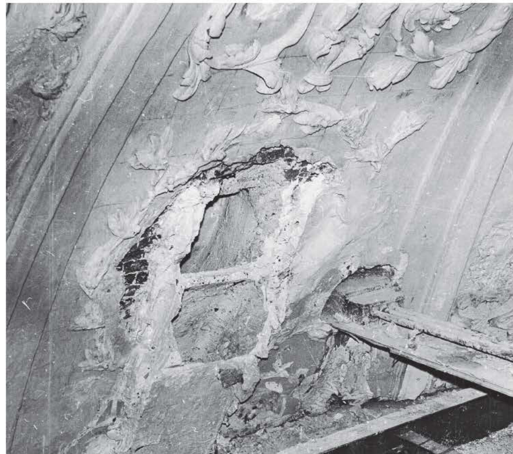
↑ Состояние свода Овального зала при разборке чердачного перекрытия во время реставрации
