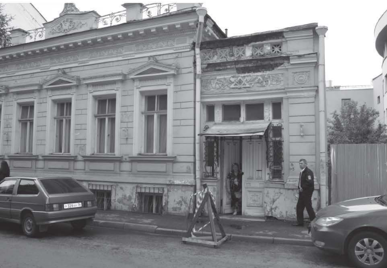
↑ Главный фасад до реставрации
