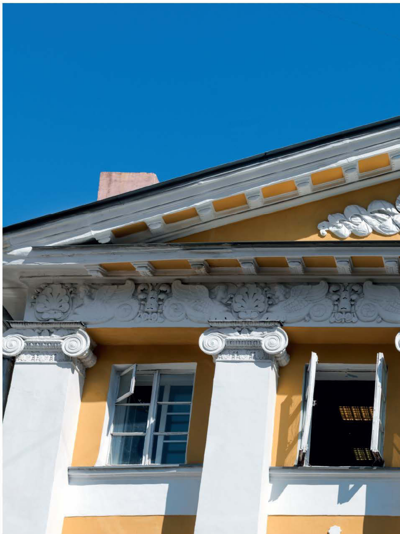
↑ Фрагмент завершающей части (фронтона карниза, фриза и капителей колонн) главного фасада после реставрации
