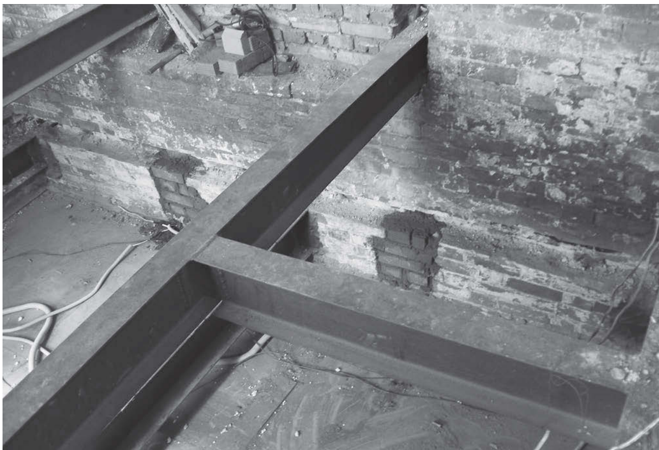
↑ Устройство пола первого этажа
