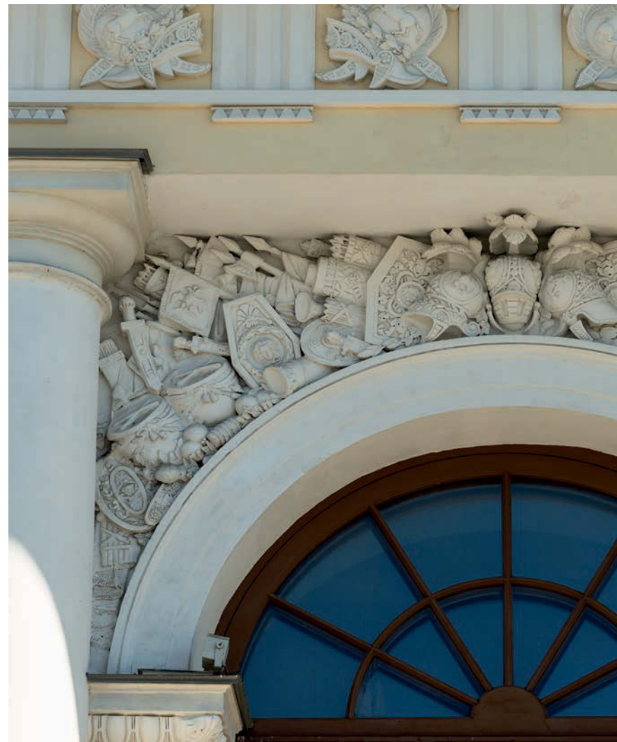
↑ Фрагмент бокового входа на восточном фасаде после реставрации
