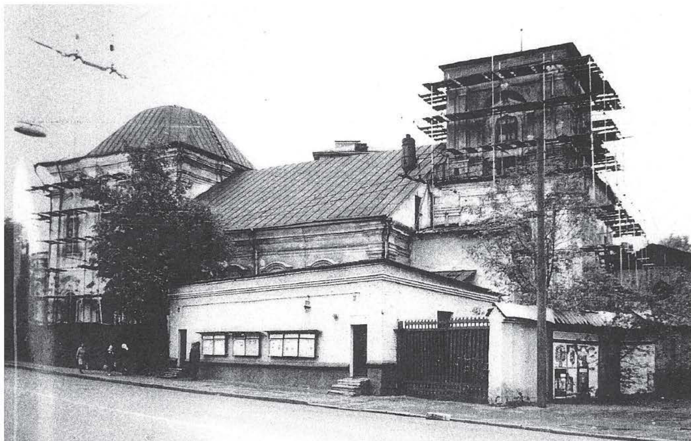
↑ Северный фасад церкви. Начаты научно-исследовательские работы под руководством архитектора Н. И. Даниленко
