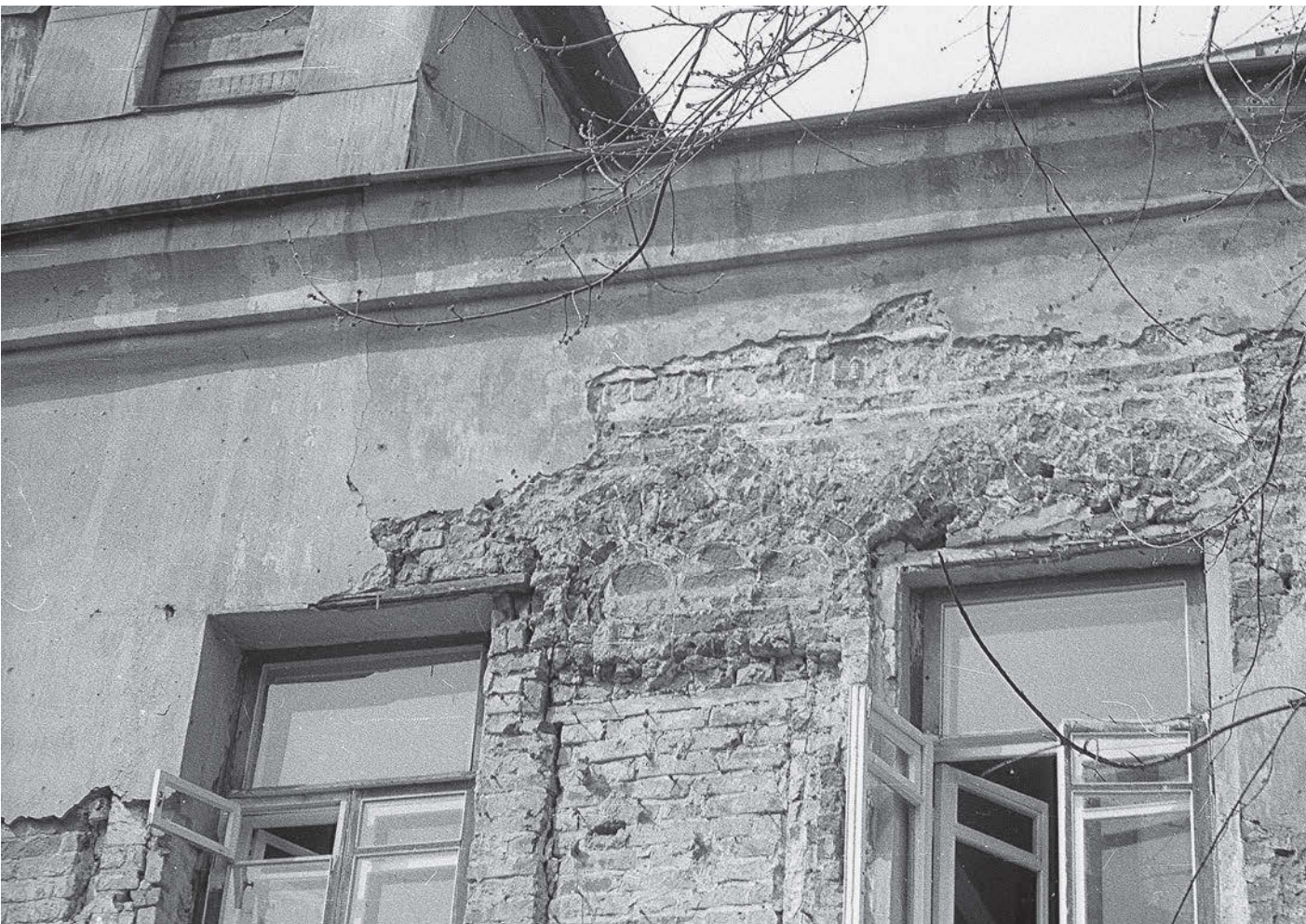
↑ Фрагмент южного фасада до реставрации (срублен декор оконного проема)
