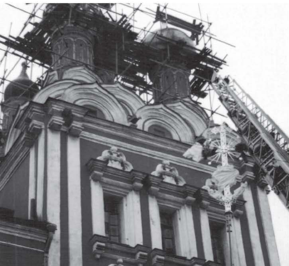
↑ Вид здания в ходе проведения реставрационных и научно-исследовательских работ. На первом этапе были восстановлены главы и установлены кресты
