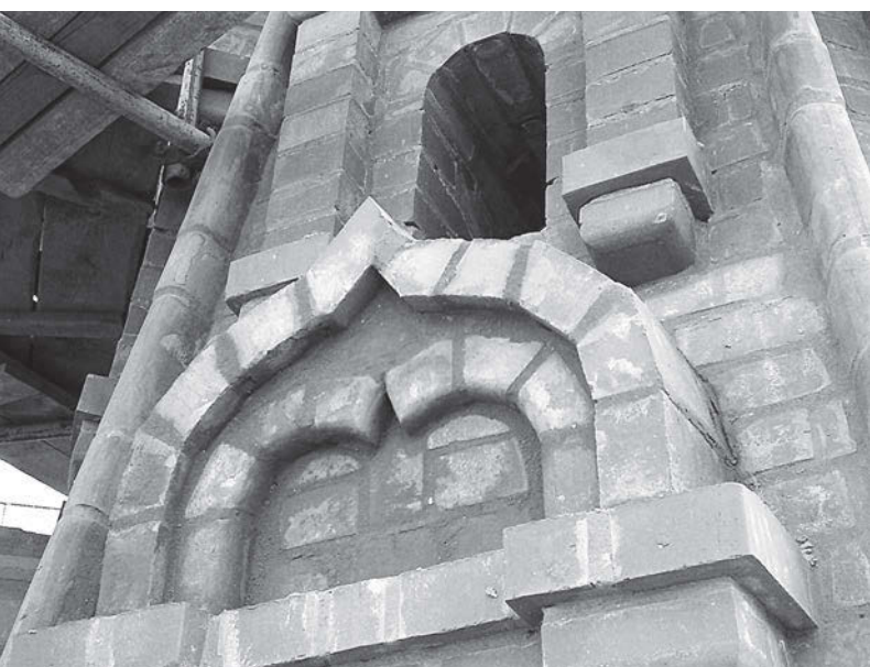
↑ Восстановление кирпичных элементов утраченного шатра
