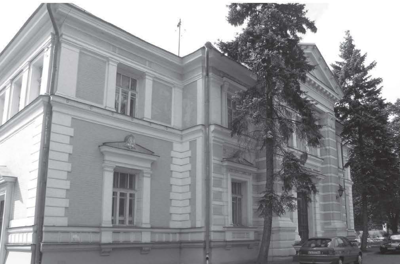
↑ Главный фасад со стороны Олсуфьевского переуллка до реставрации
