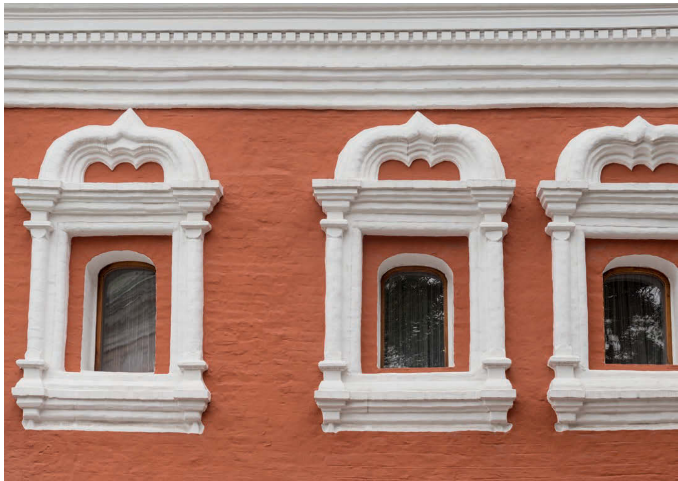
↑ Фрагмент северного фасада после реставрации
