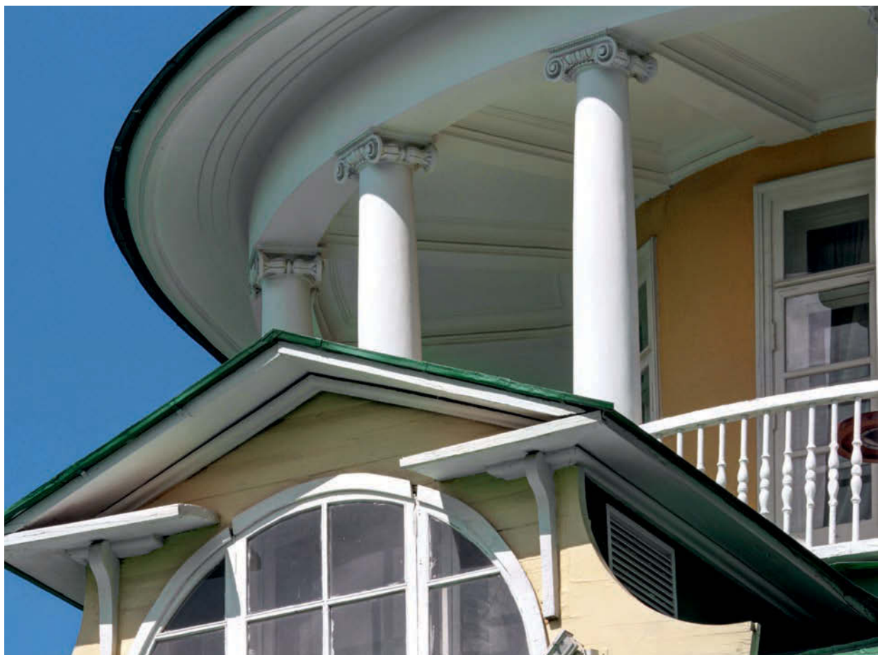
↑ Фрагмент люкарны над парадным залом ротонды (второй этаж) и колоннады «фонарика» (третий этаж) после реставрации
