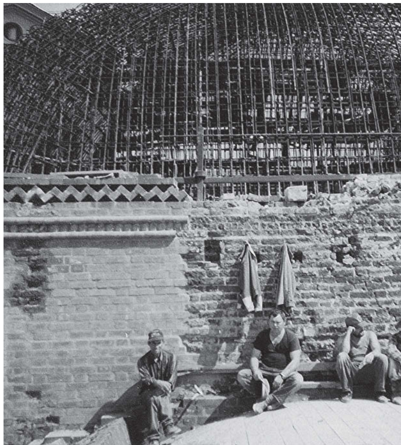
↑ Восстановление стен, свода и покрытия четверика
