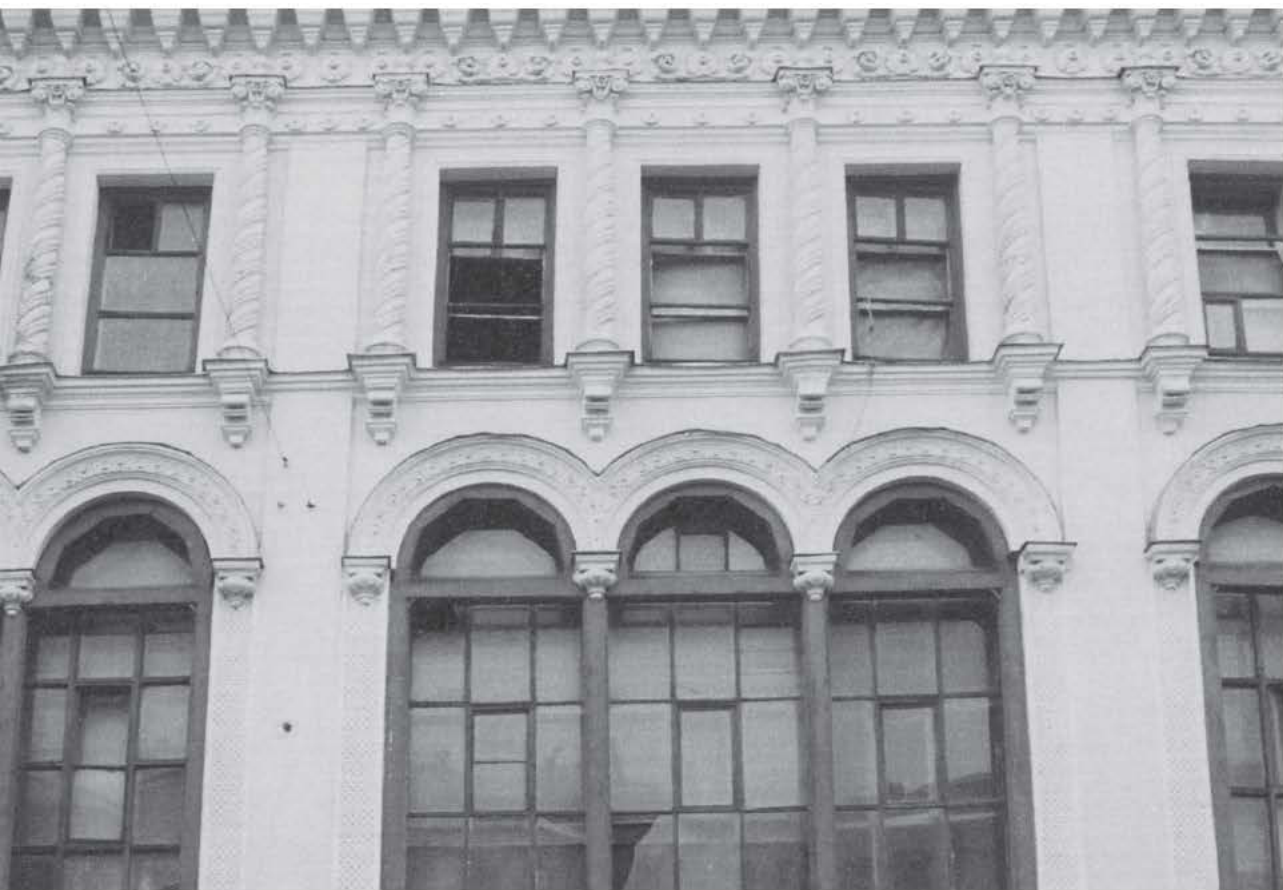
↑ Уличный фасад до реставрации
