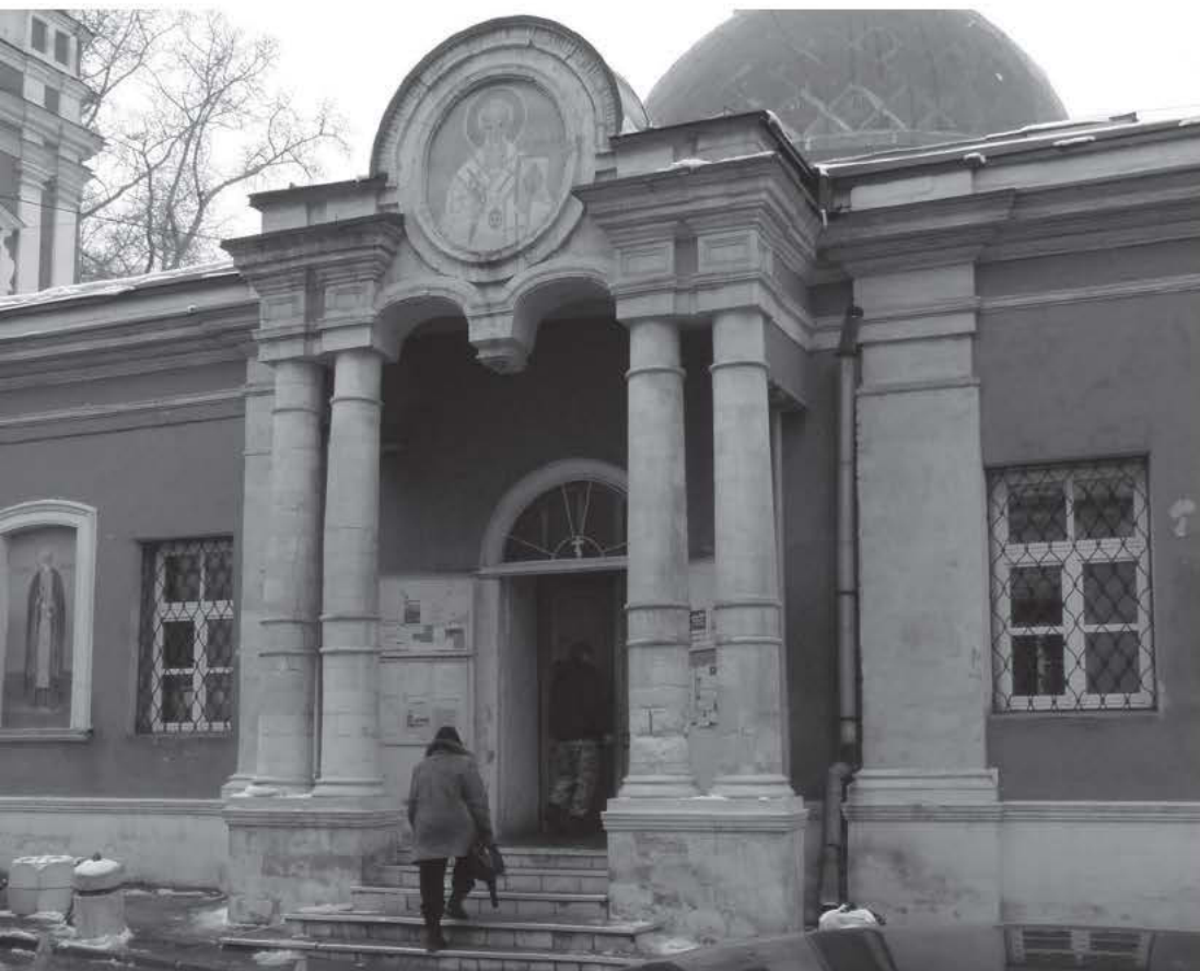
↑ Главный фасад до реставрации
