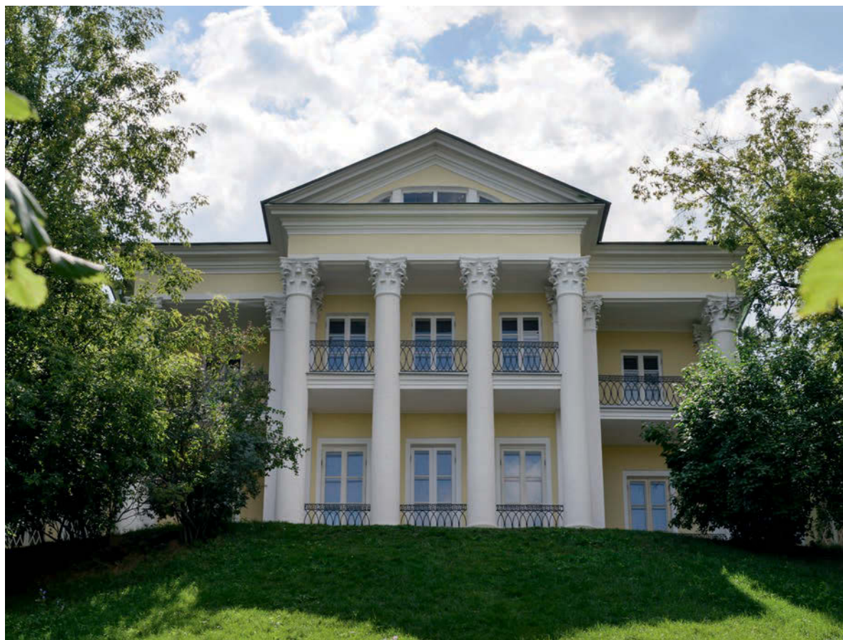
↑ Общий вид парадного фасада Летнего домика со стороны Москвы-реки после реставрации
