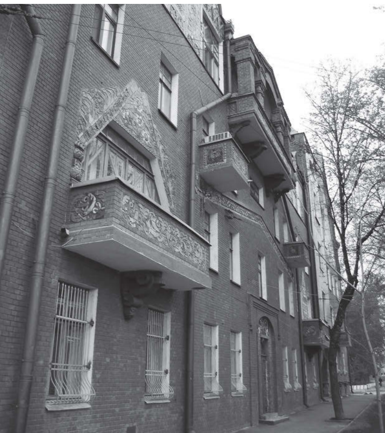
↑ Балконы фасада по Соймоновскому проезду
