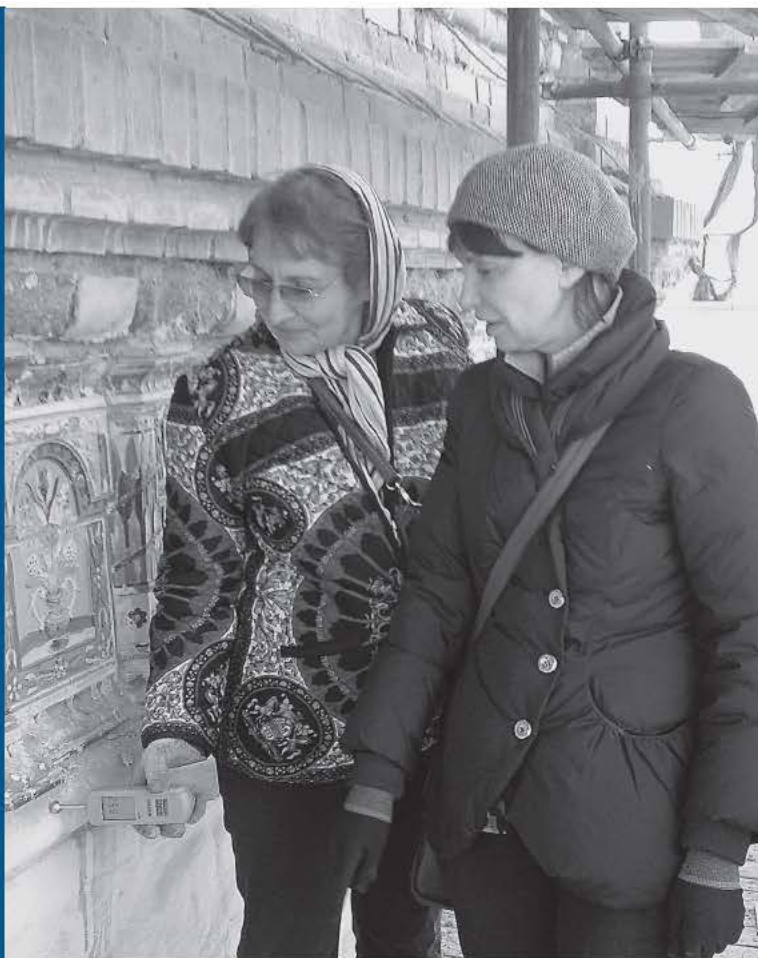
↑ Определение технического состояния фриза колокольни в Бутырской слободе, реставрация, 2011
