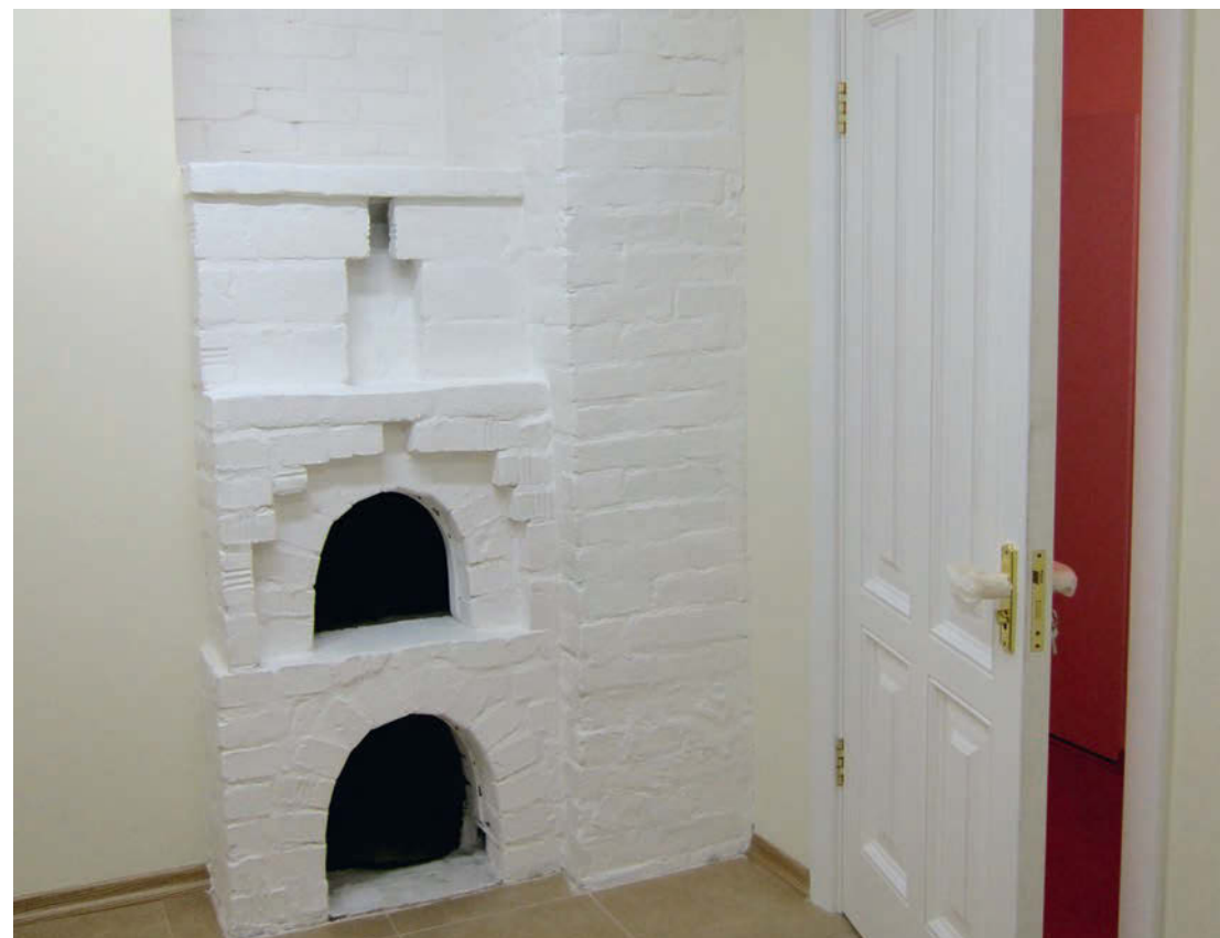
↑ Печь в подвале после реставрации
