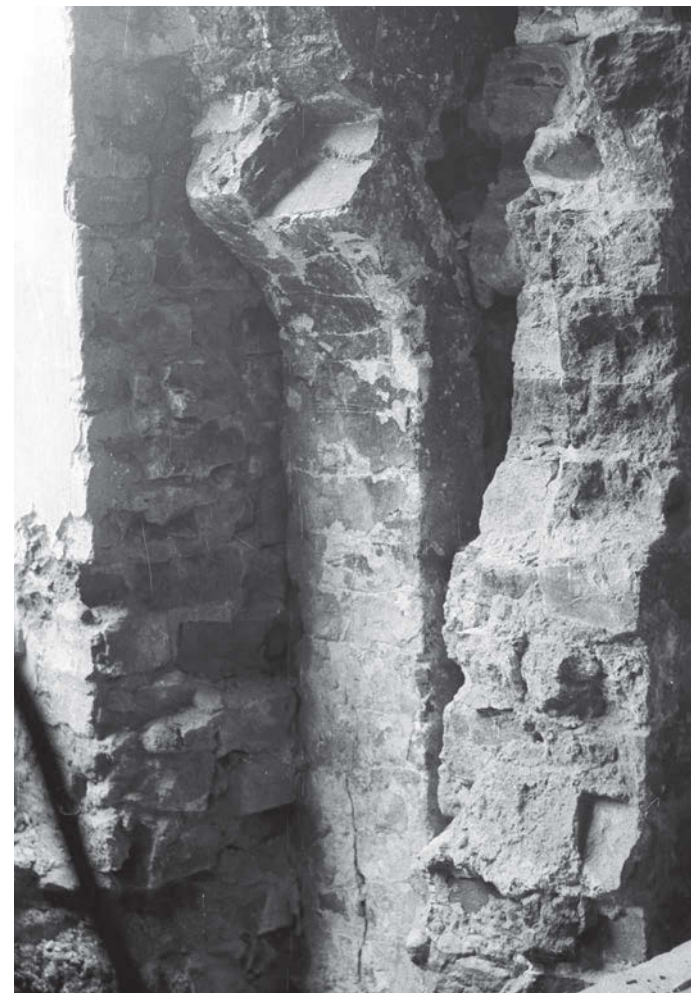
↑ Зондаж внутренней стены. Виден фрагмент раскрытого дверного проема
