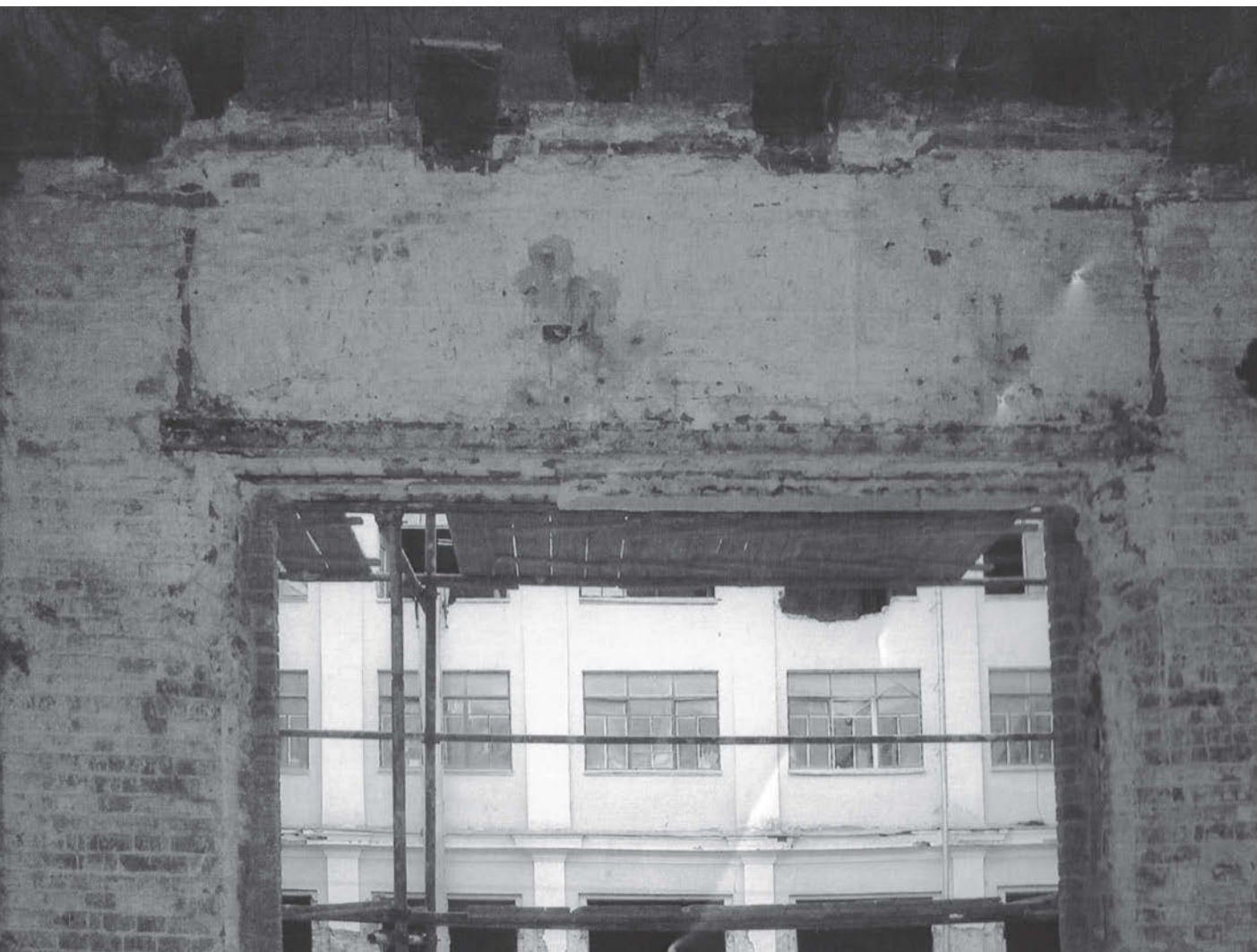
↑ Помещение третьего этажа с гнездами для балок перекрытия до реставрации
