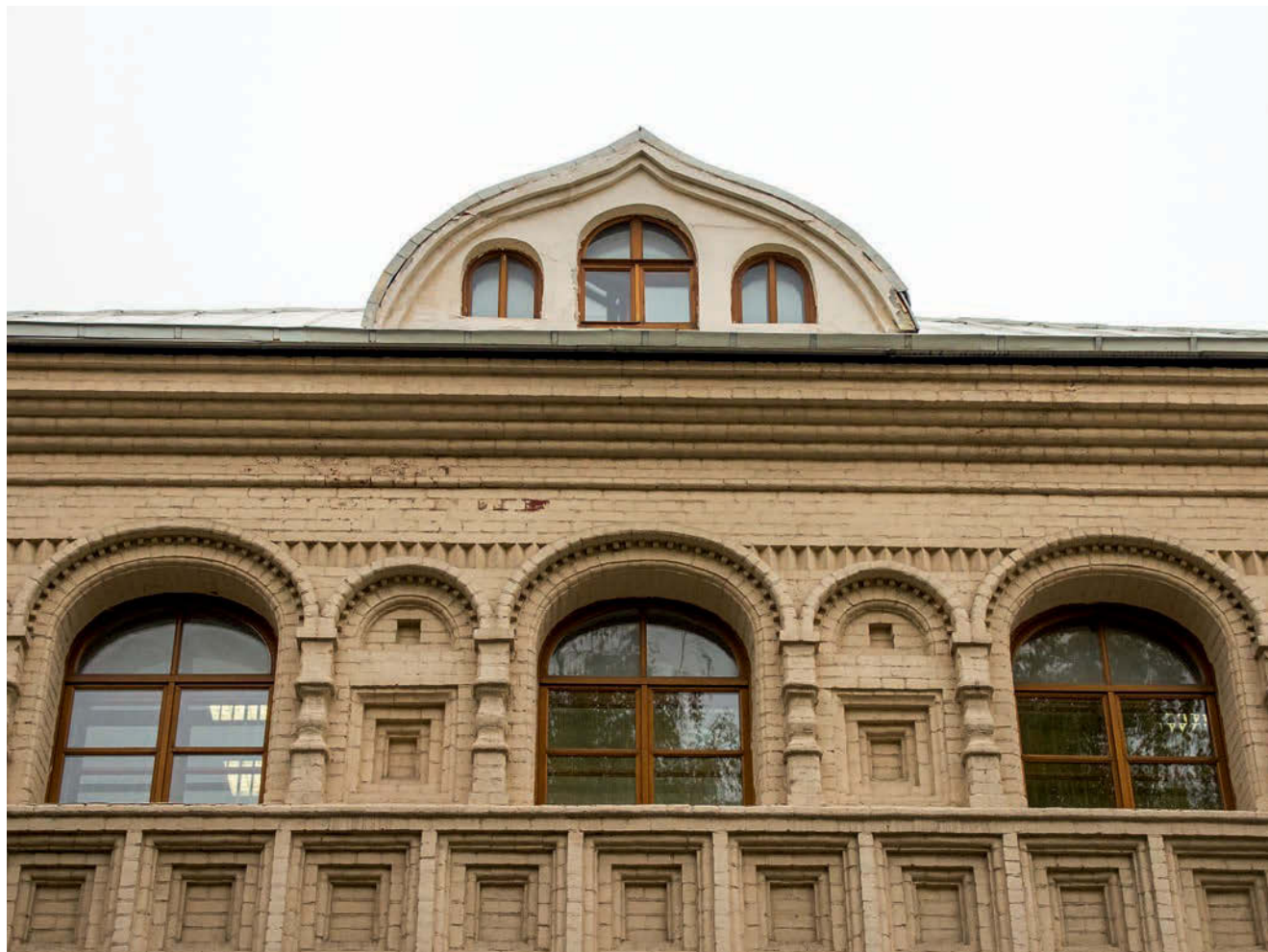
↑ Фрагмент главного фасада и восстановленные окна светелки
