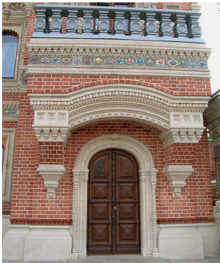
↑ Фрагмент главного фасада после реставрации
