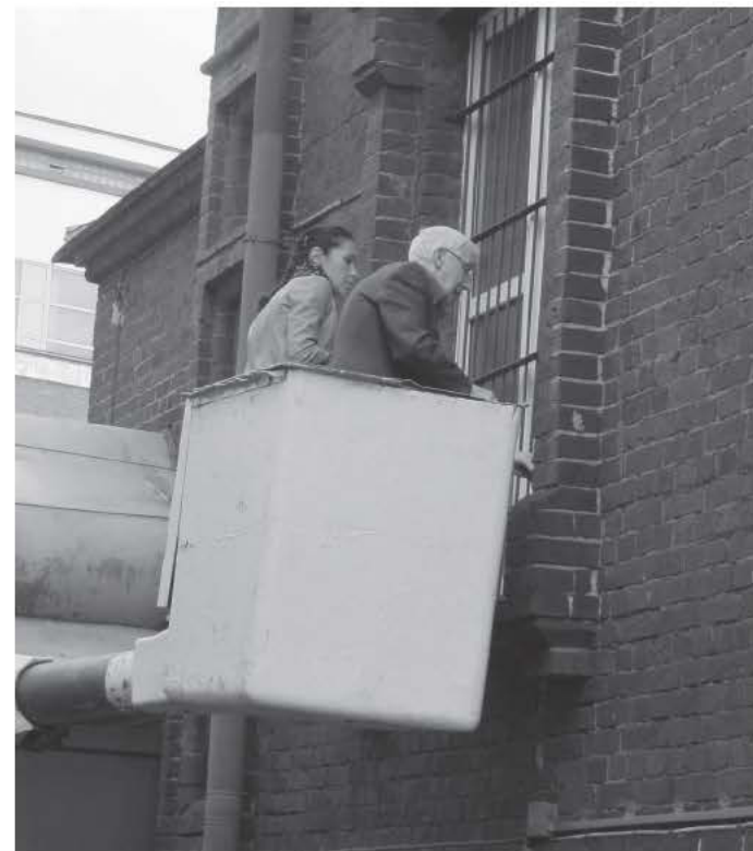
↑ Москва, Пречистенская набережная, дом 29. На обмерах, 2014
