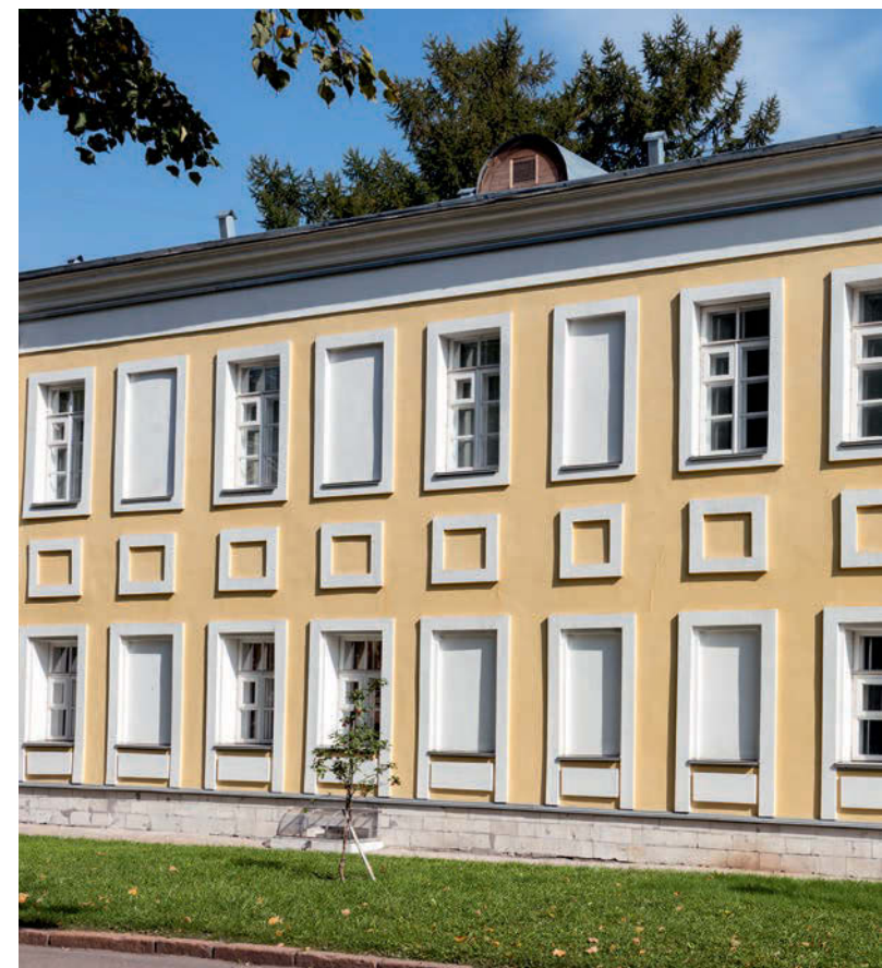
↑ Корпус «В» после реставрации
