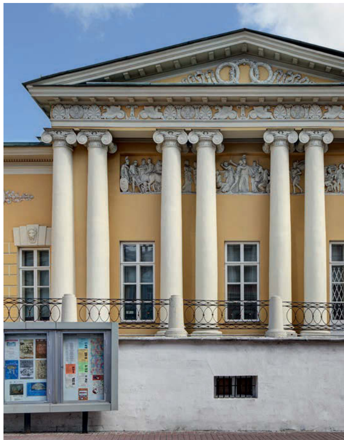
↑ Портик со стороны Хрущевского переулка после реставрации
