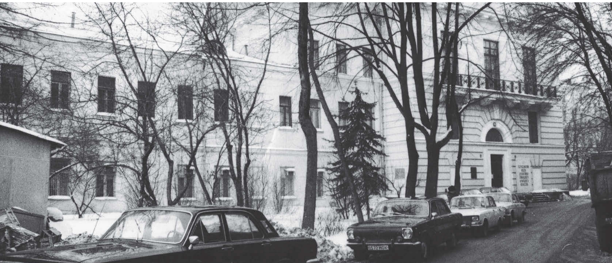
↑ Корпус «А» и корпус «З» до реставрации
