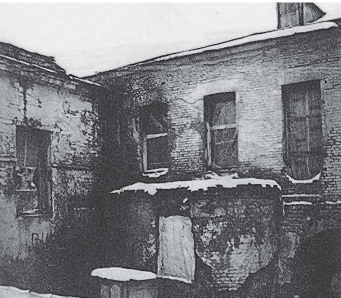
↑ Фасад дворового флигеля до реставрации
