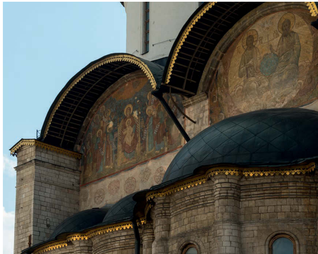
↑ Южный угол восточного фасада после реставрации
