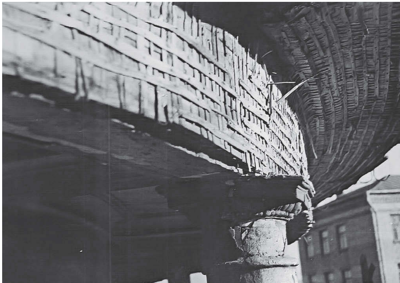
↑ Капитель колонны, фриз и карниз колоннады ротонды (второй этаж) в период реставрации
