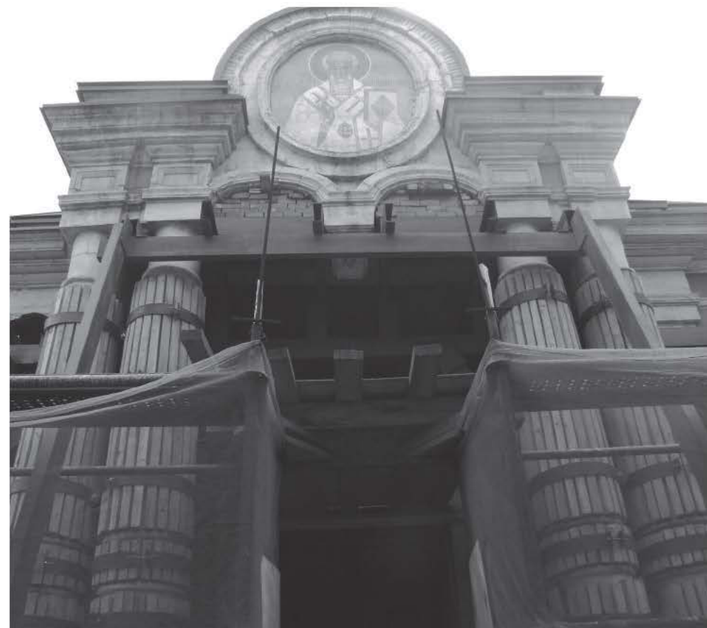
↑ Главный вход во время реставрации. Временные крепления для выпрямления колонн
