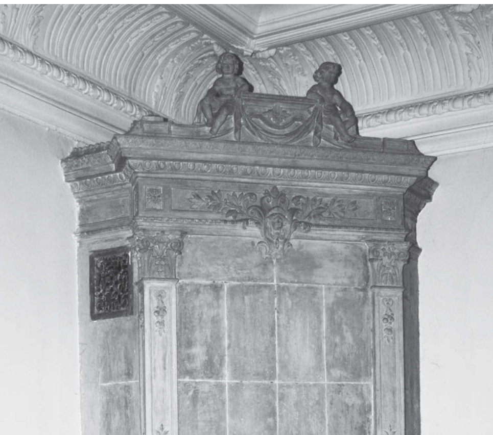
↑ Фрагмент камина до реставрации
