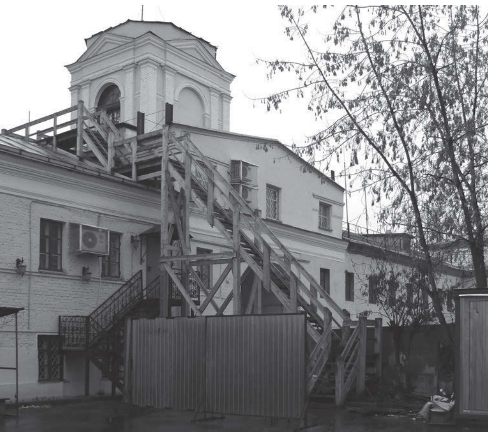
↑ Фрагмент дворового фасада во время реставрации, установлена временная лестница для рабочих и подачи материалов
