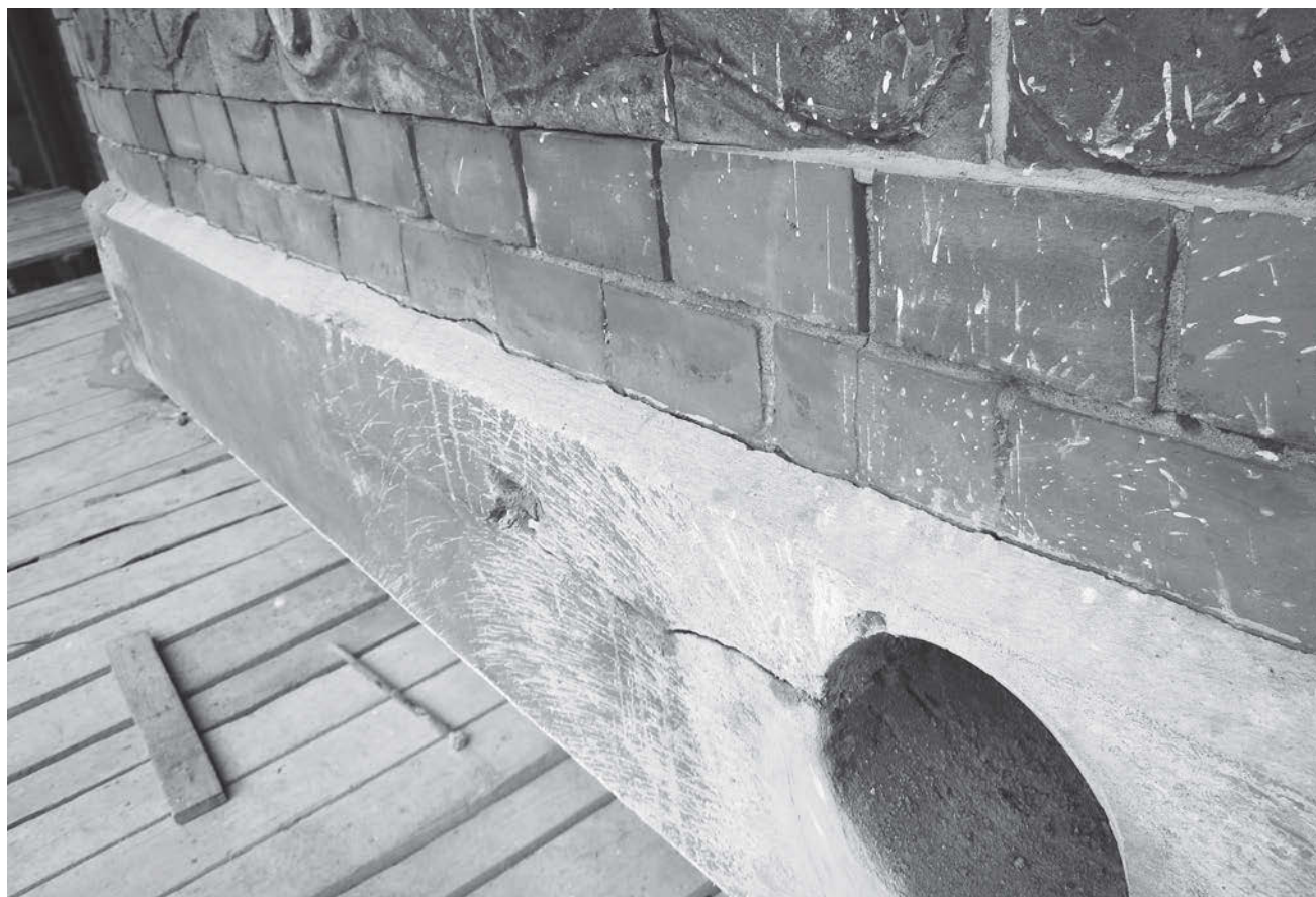
↑ Уникальный способ ремонта несущих конструкций плиты балкона с сохранением майоликовых изразцов
