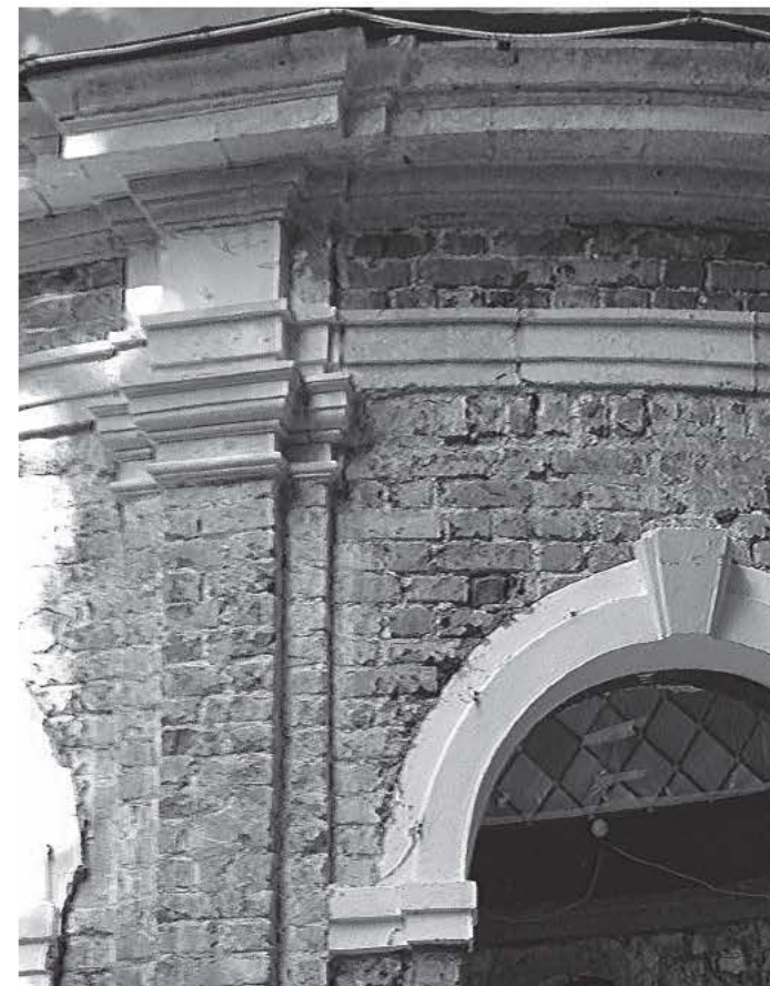
↑ Фрагмент кладки, раскрытой в ходе реставрации
