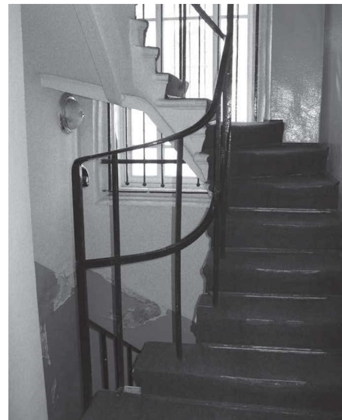
↑ Внутренняя лестница до реставрации
