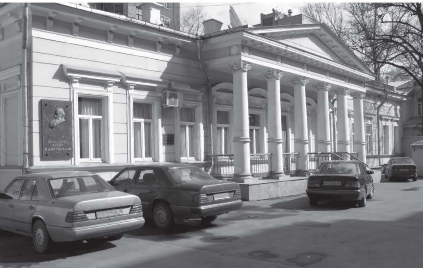
↑ Главный фасад дома до реставрации
