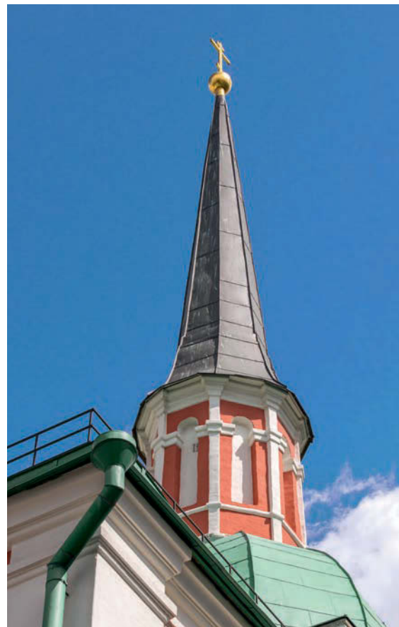
↑ Фрагмент западной части собора. Шпиль после выполнения реставрационных работ
