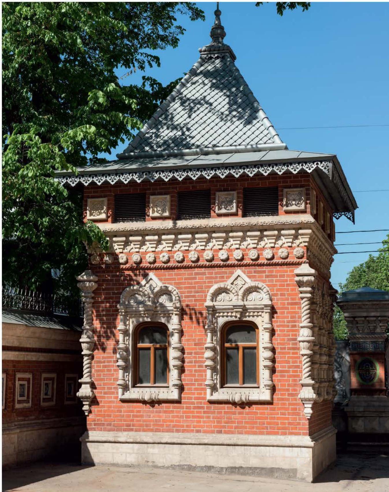
↑ Воздухозаборная шахта после реставрации
