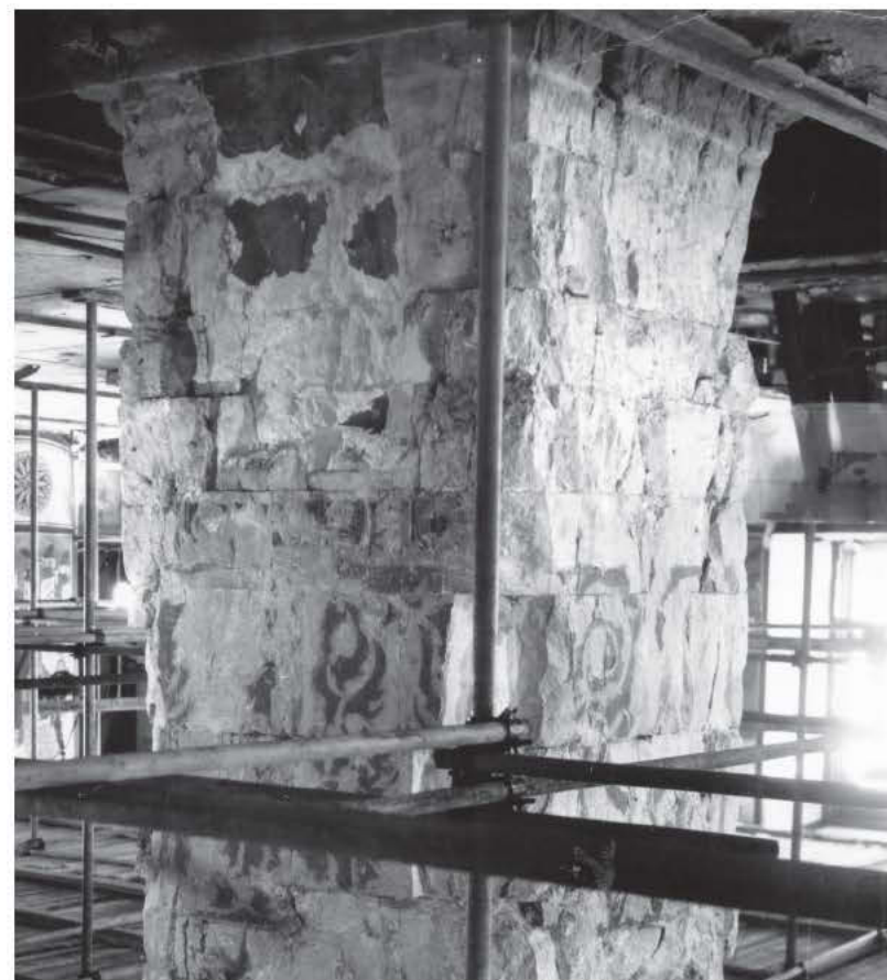
↑ Столб Грановитой палаты, раскрытый в процессе реставрационных работ
