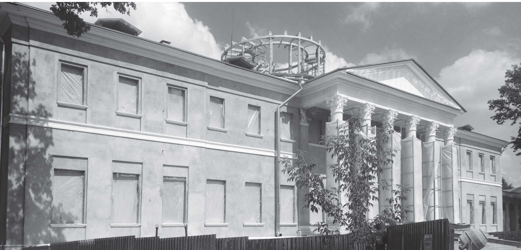
↑ Фрагмент фасада дома во время реставрации
