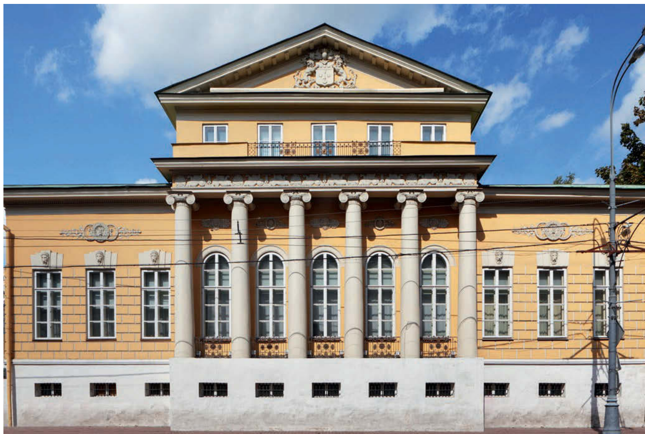
↑ Главный дом после реставрации
