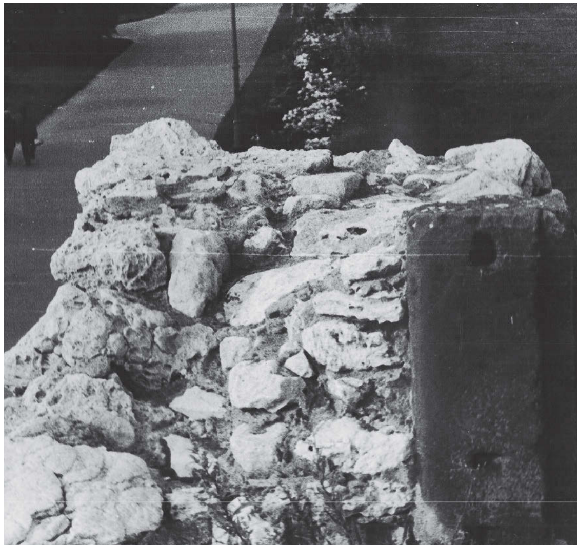
↑ Фрагмент циклопической кладки Грота
