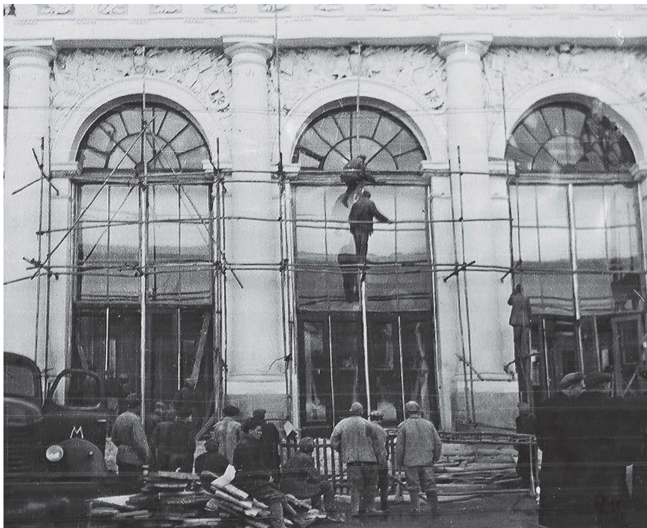
↑ Установка лесов для производства реставрационных работ
