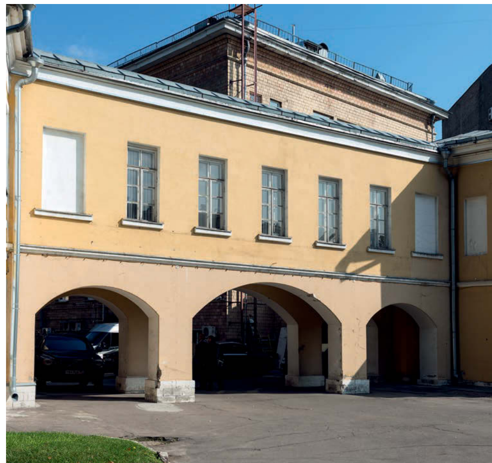
↑ Переход между восточным флигелем и корпусом «В» после реставрации
