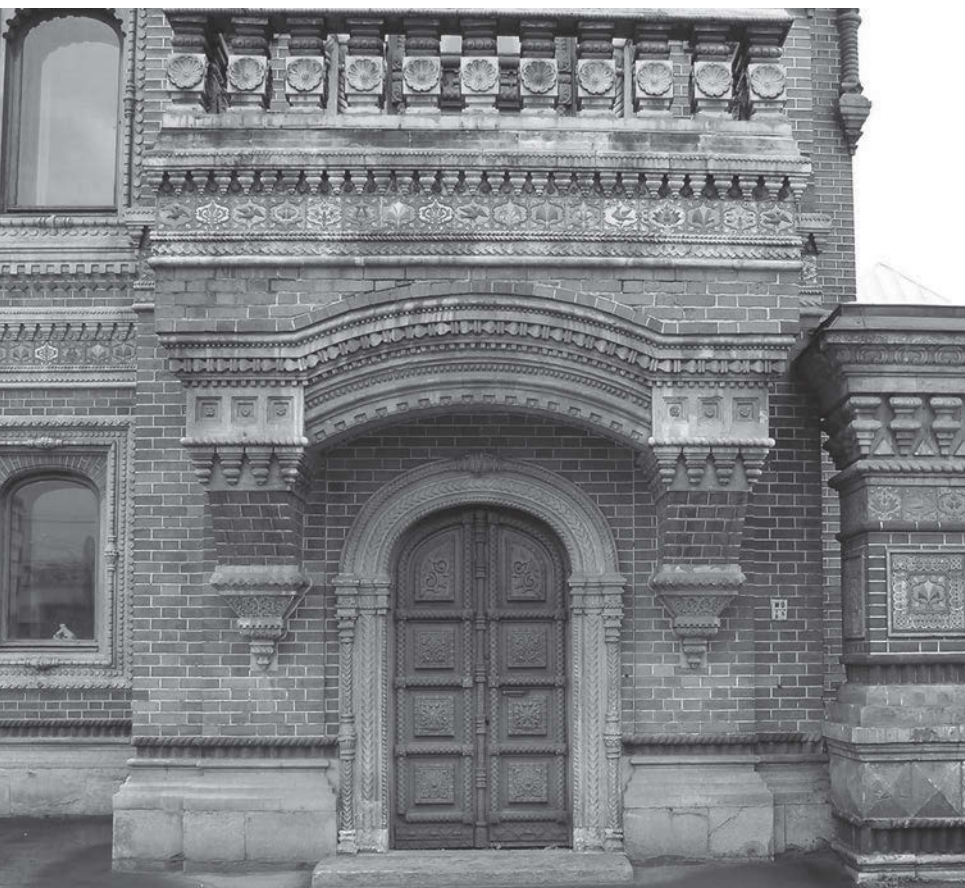
↑ Фрагмент главного фасада до реставрации
