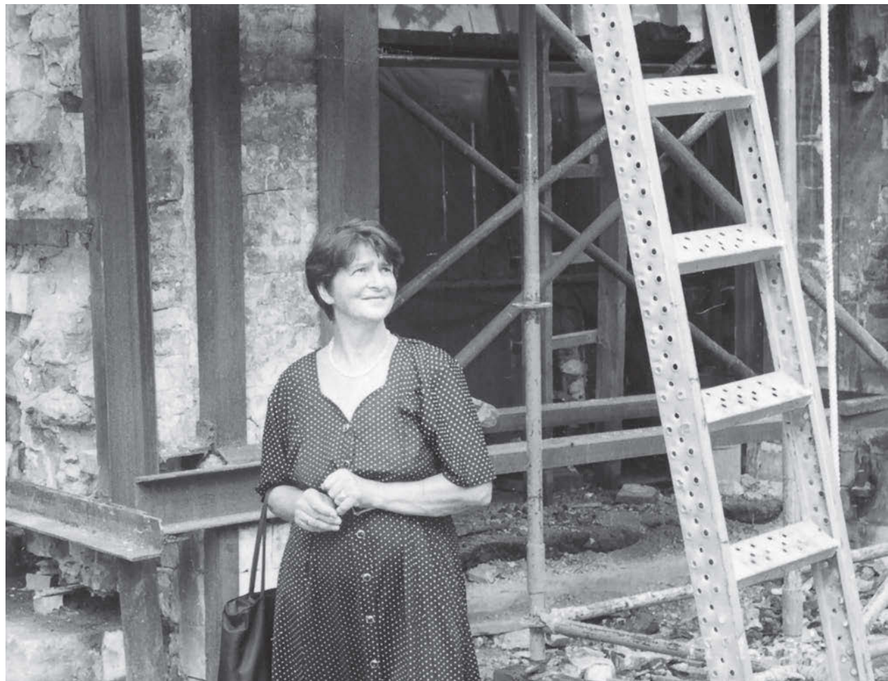
↑ Москва, церковь Знамени Божией Матери. Ленинский проспект, дом 10, строение 5. Крепление колонны, 2004
