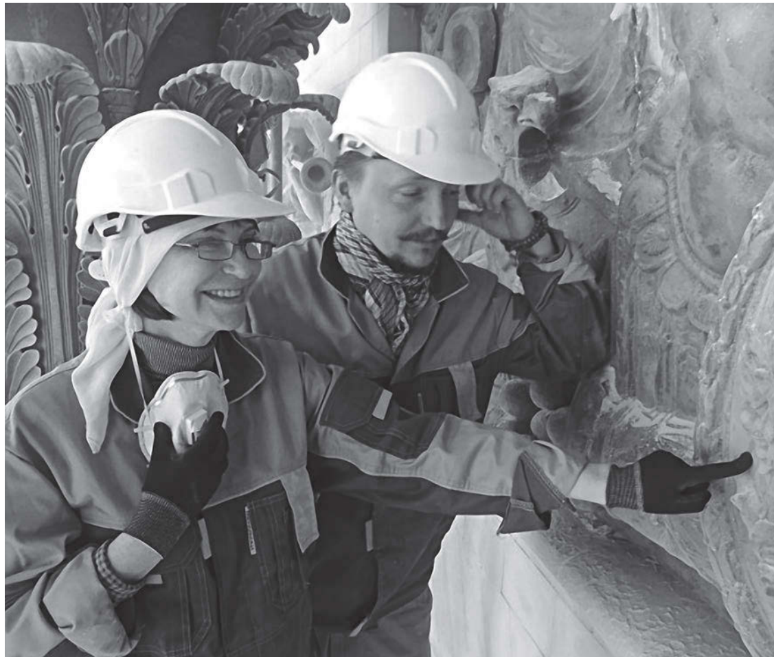
↑ Москва. Триумфальная арка. Осмотр чугунных литых элементов фриза в ходе ведения авторского надзора арки. Главный архитектор проекта Н.И. Даниленко, руководитель реставрационных работ С.В. Крипак, 2012
