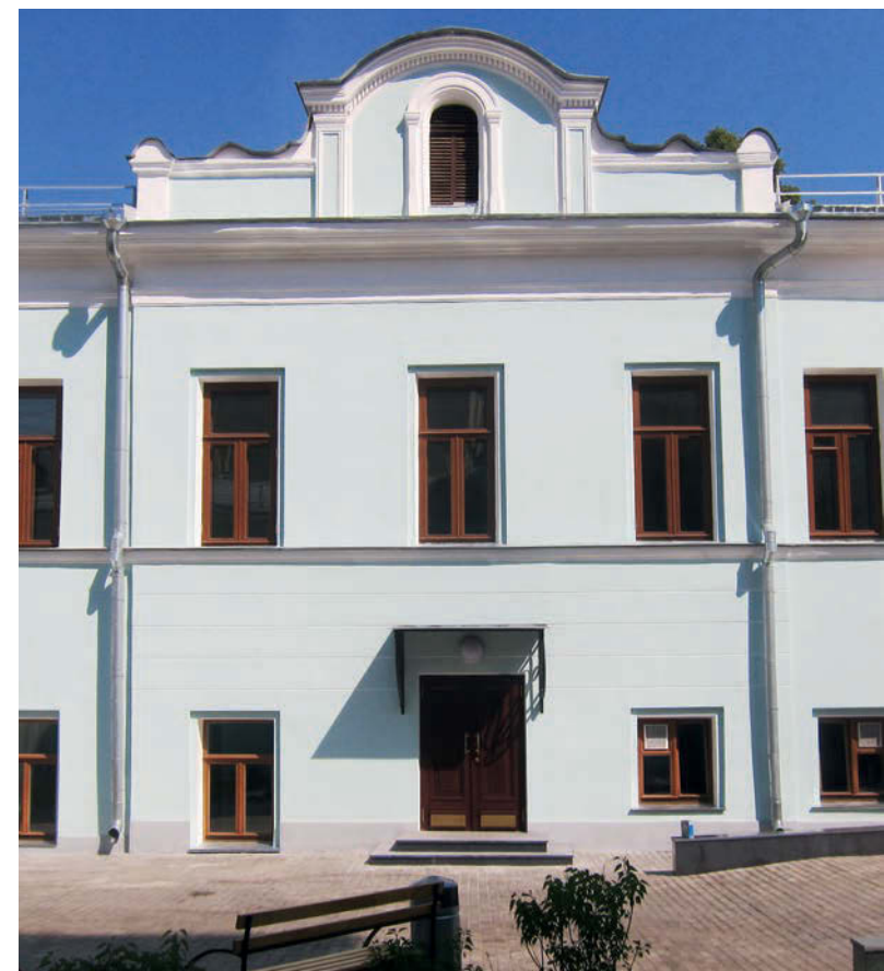
↑ Фрагмент дворового фасада после реставрации
