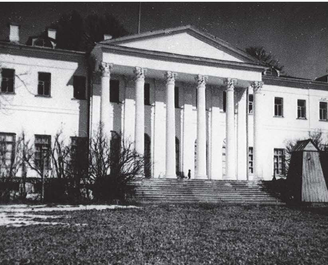
↑ Главный фасад дома до реставрации
