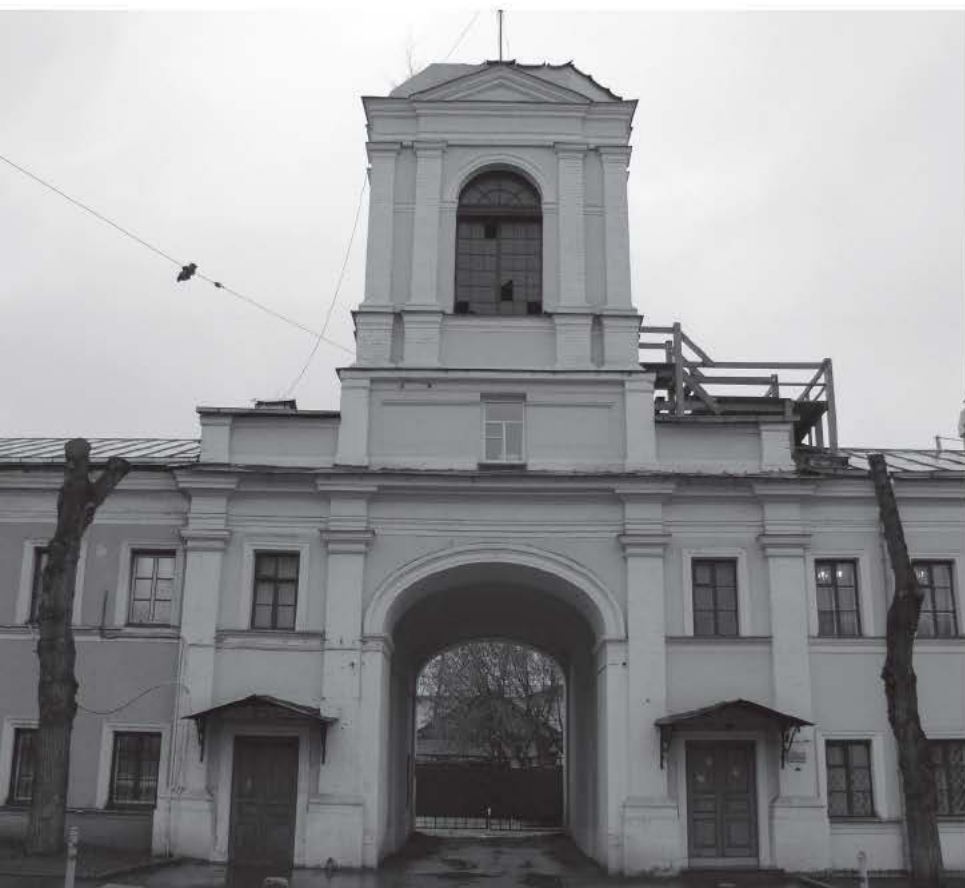
↑ Фрагмент главного фасада до реставрации
