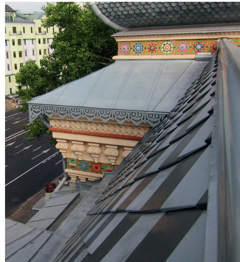
↑ Фрагмент кровли главного дома после реставрации
