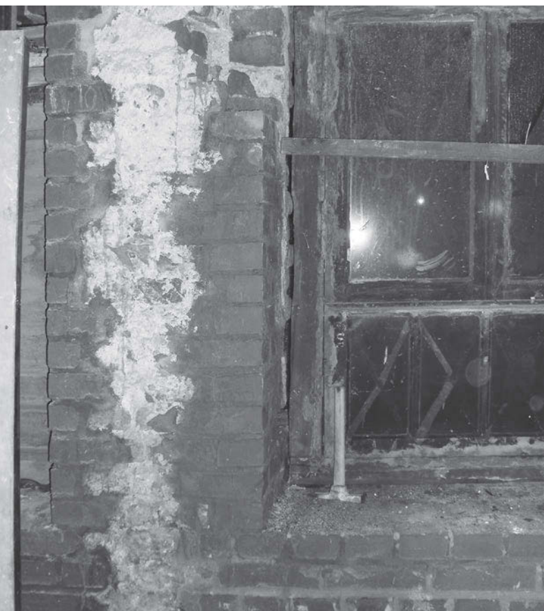
↑ Стены здания до реставрации
