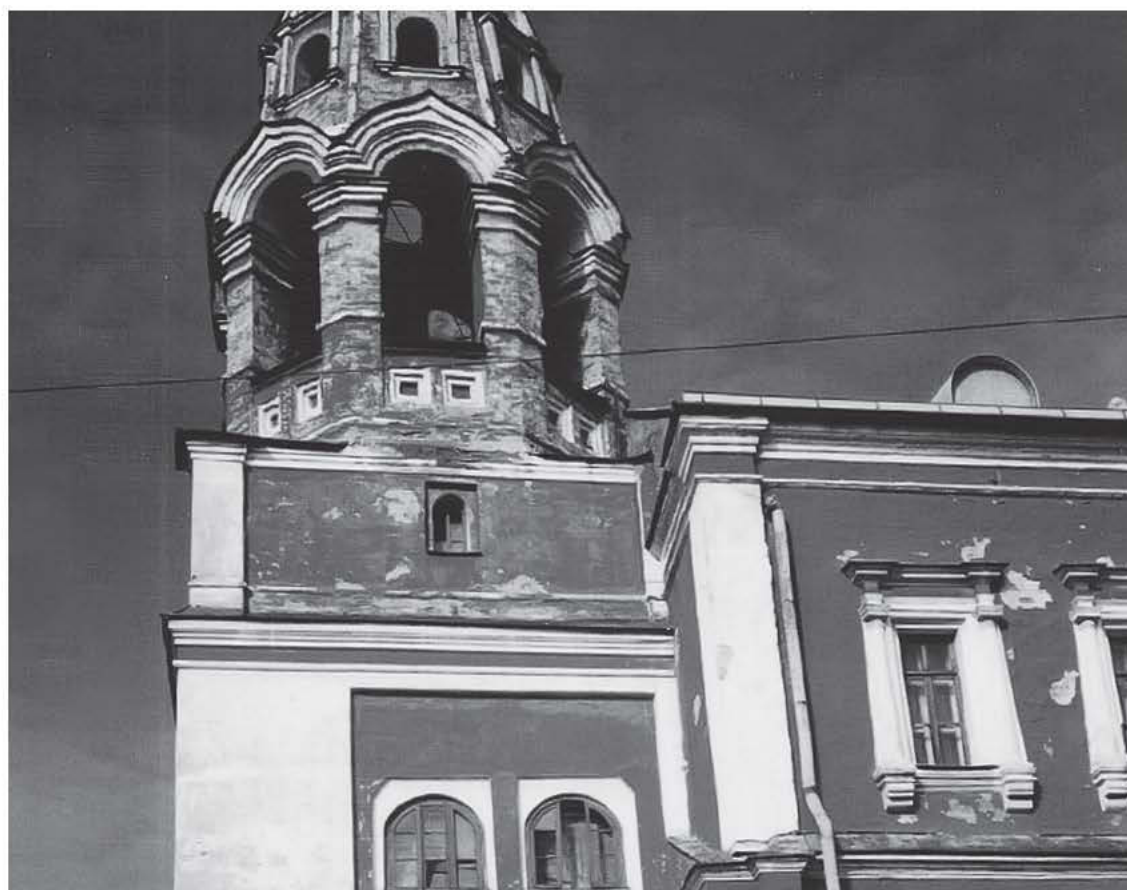
↑ Фрагмент южного фасада до реставрации
