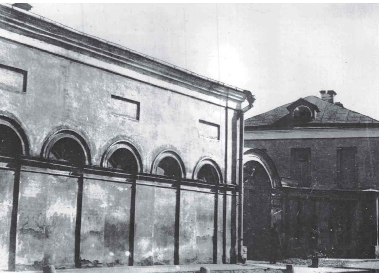
↑ Фасад конюшни и торцевой фасад людского корпуса до реставрации
