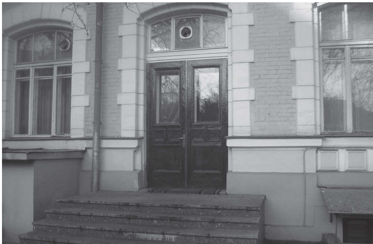
↑ Фрагмент дворового фасада (юго-восточного) до реставрации
