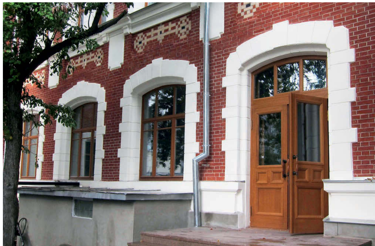
↑ Фрагмент дворового фасада (юго-восточного) после реставрации
