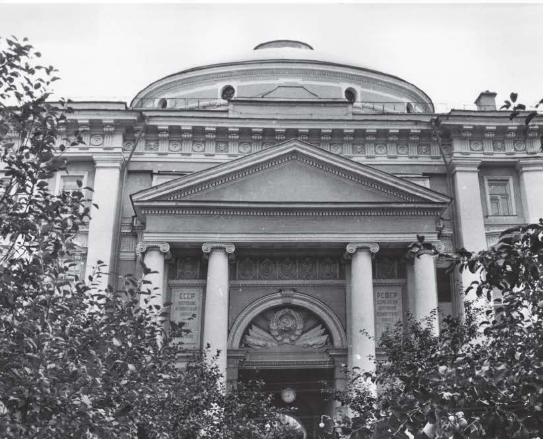
↑ Фрагмент фасада здания Сената в Московском Кремле до реставрации
