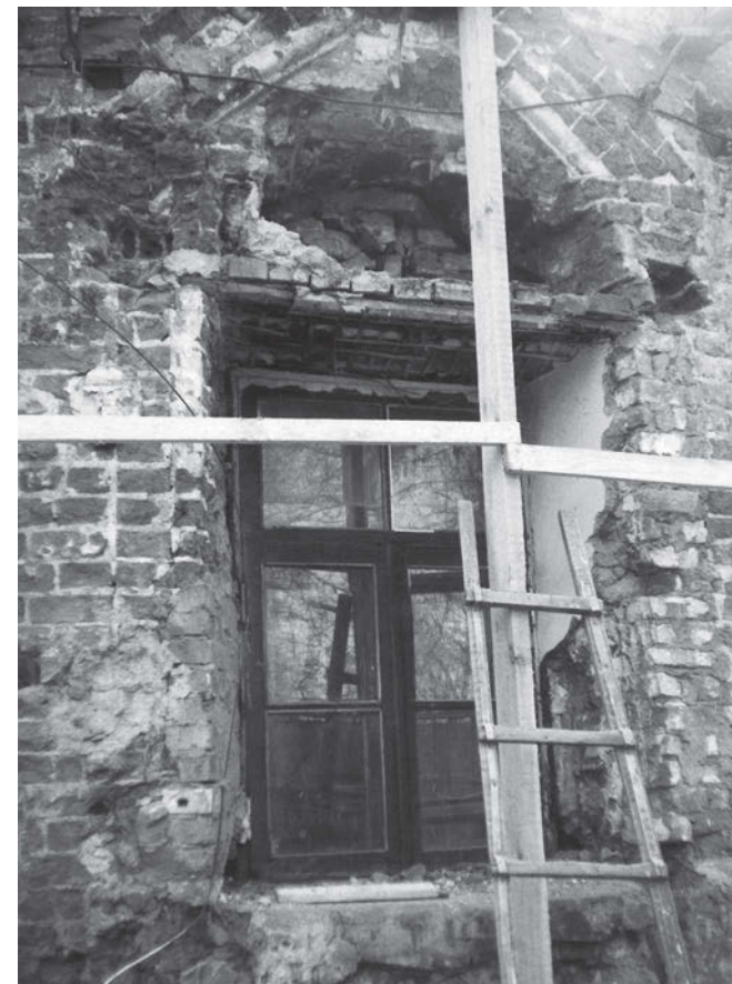
↑ Реставрация перемычки и кладки стен
