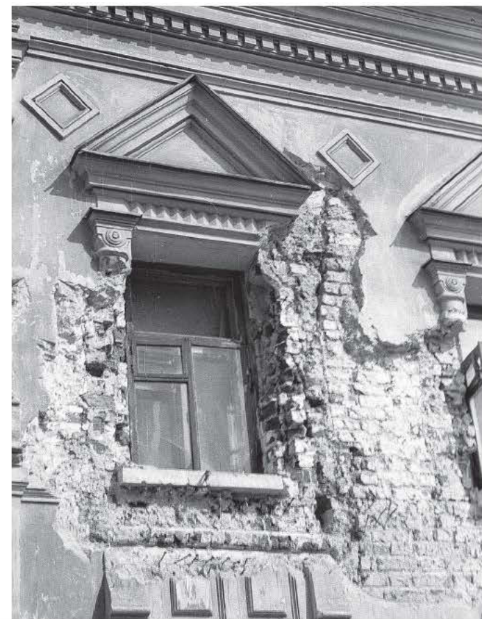
↑ Зондаж оконного проема второго этажа
