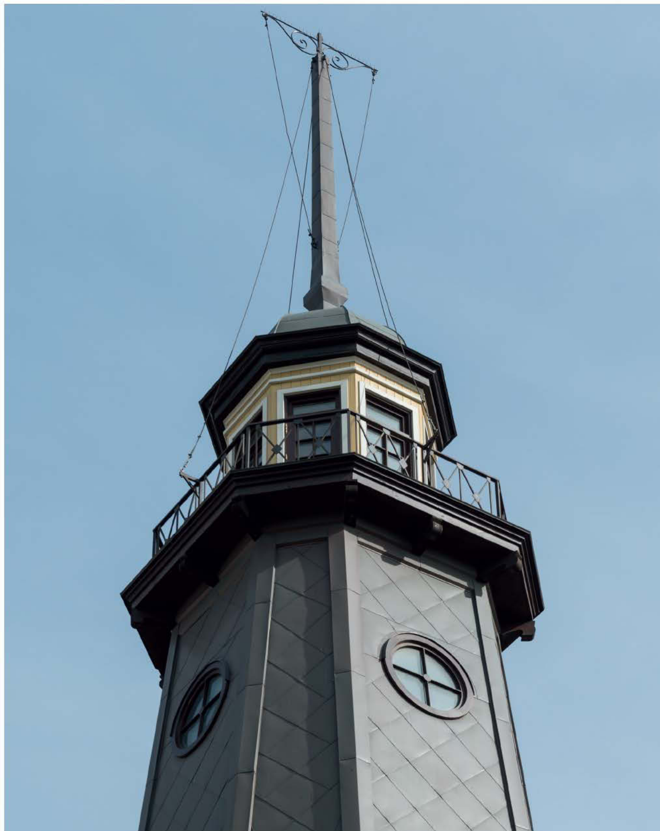
↑ Восстановленная смотровая площадка на деревянных веерных балках
