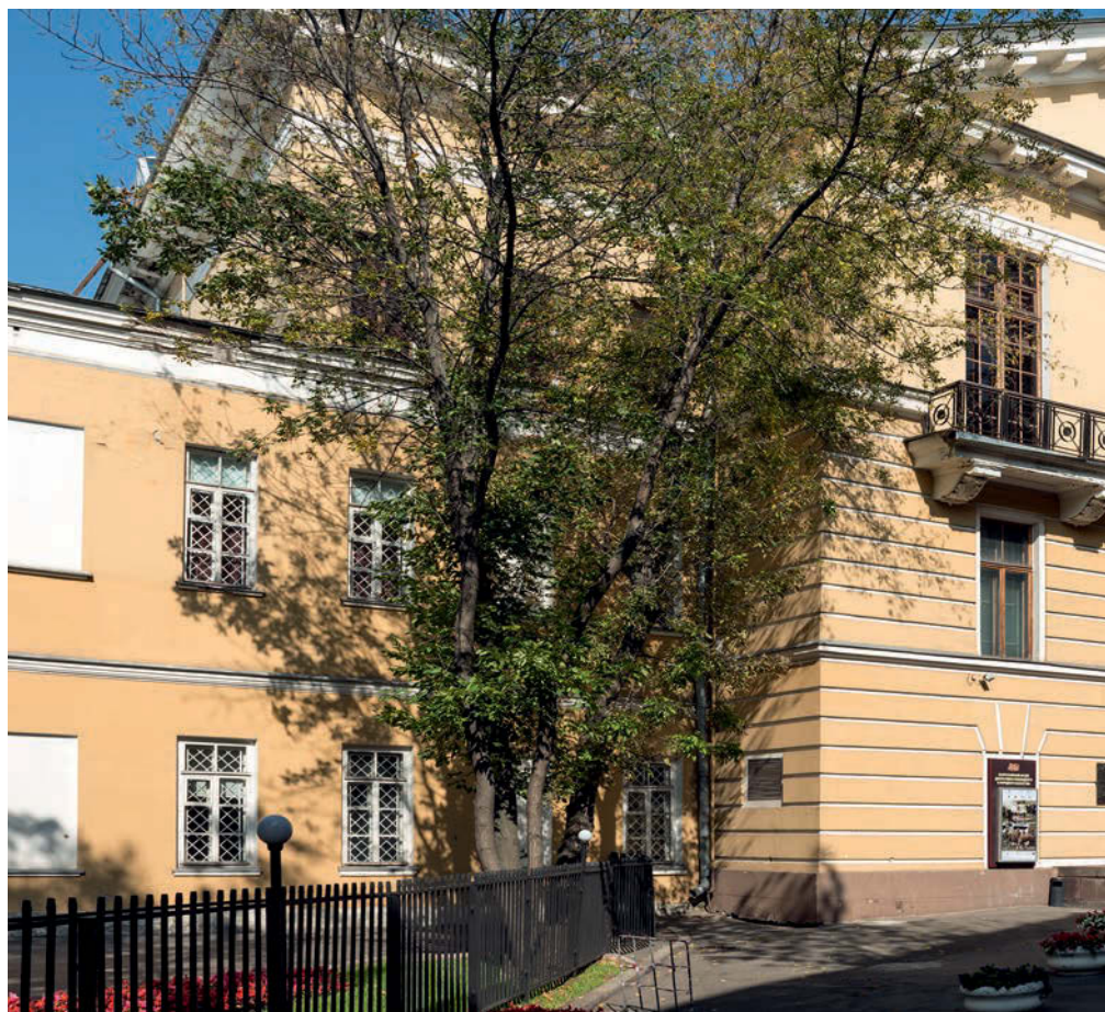
↑ Корпус «А» и корпус «З» после реставрации
