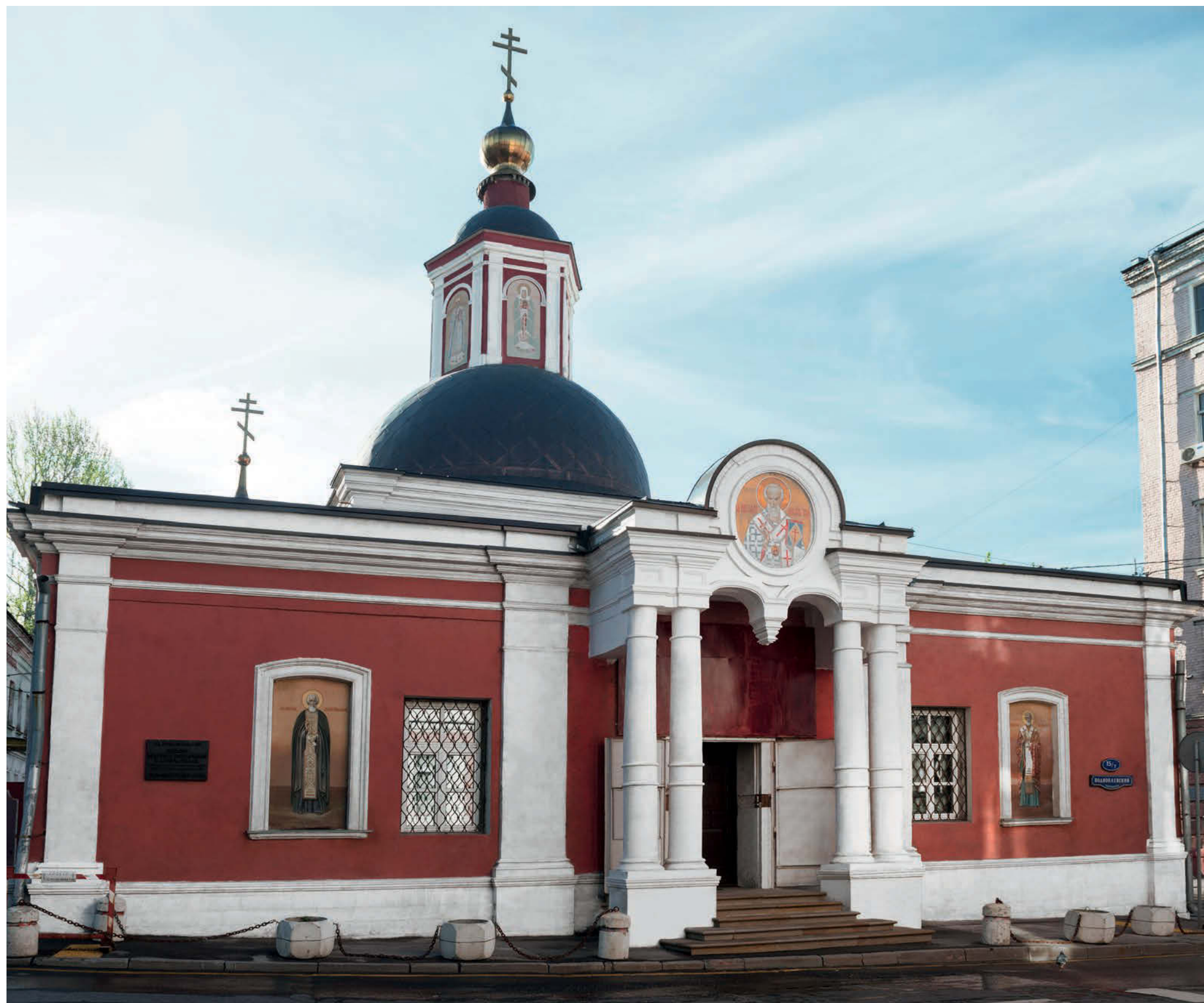
↑ Главный фасад. Главный вход в храм после реставрации
