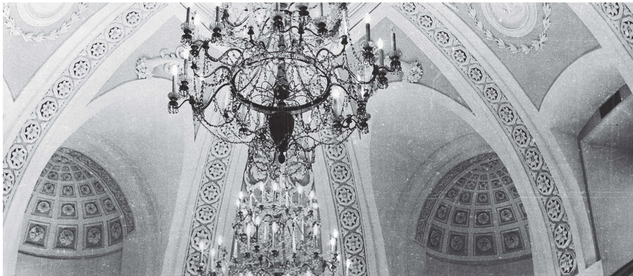
↑ Фрагмент сводчатого потолка Овального зала после реставрации
