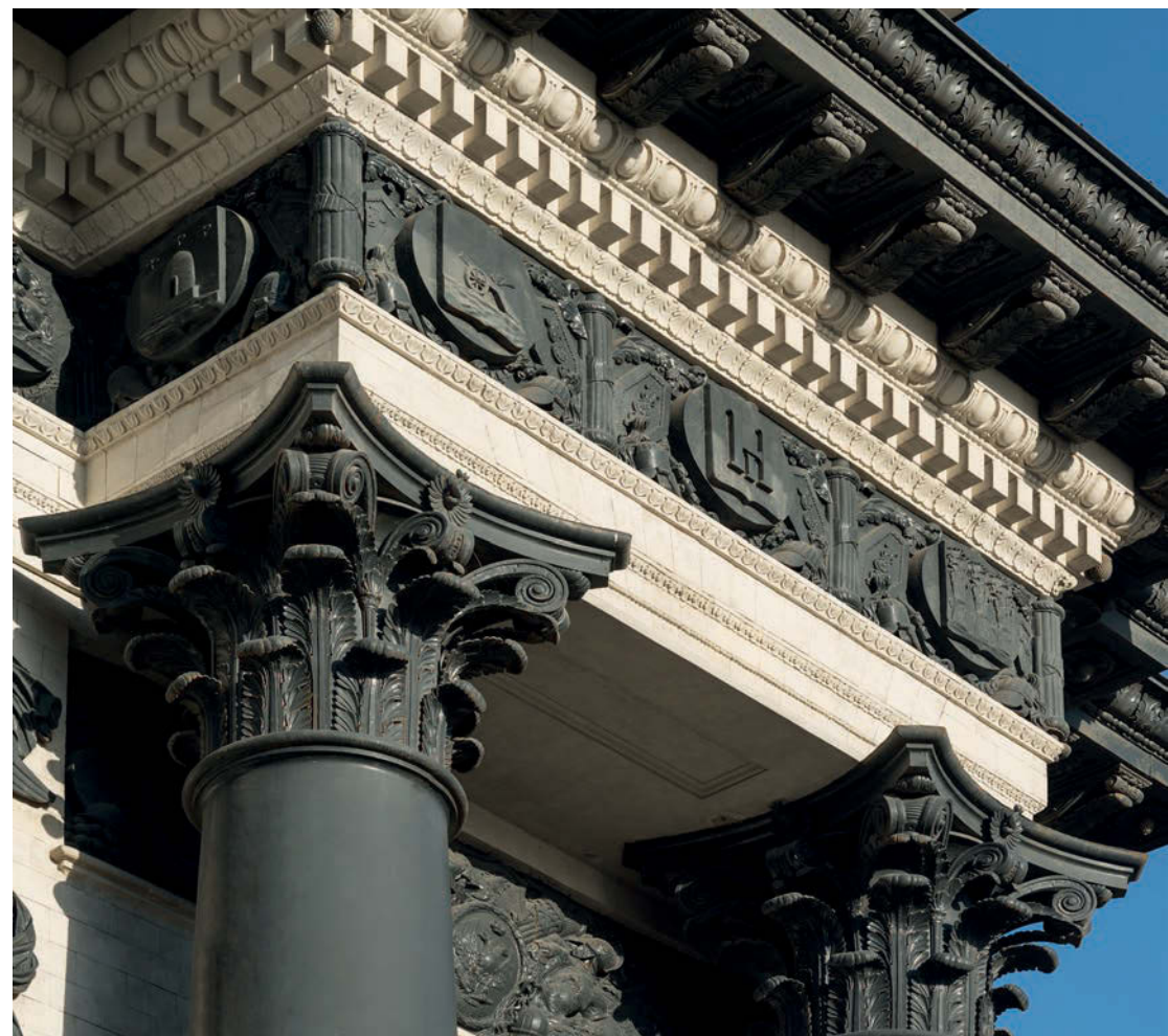
↑ Завершение двухколонного ризалита после воссоздания
