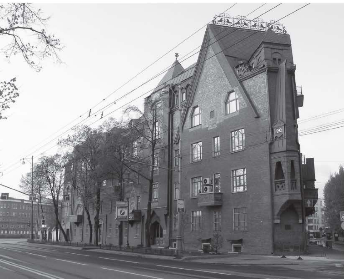
↑ Фасад со стороны Соимоновского проезда до реставрации балконов
