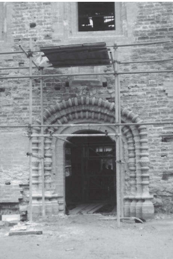
↑ Реставрация кладки стен у входа в трапезную
