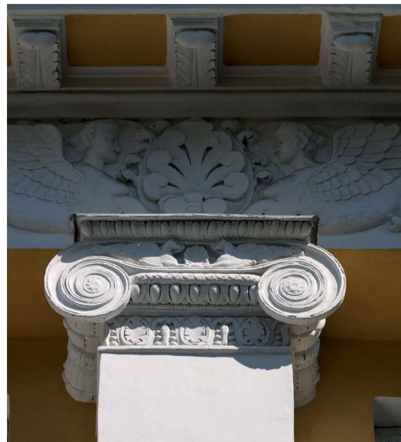
↑ Фрагмент завершающей части портика главного дома после реставрации
