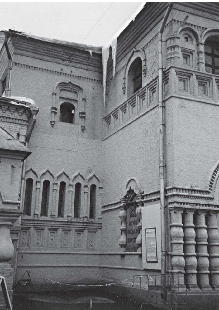
↑ Фрагмент главного фасада до реставрации
