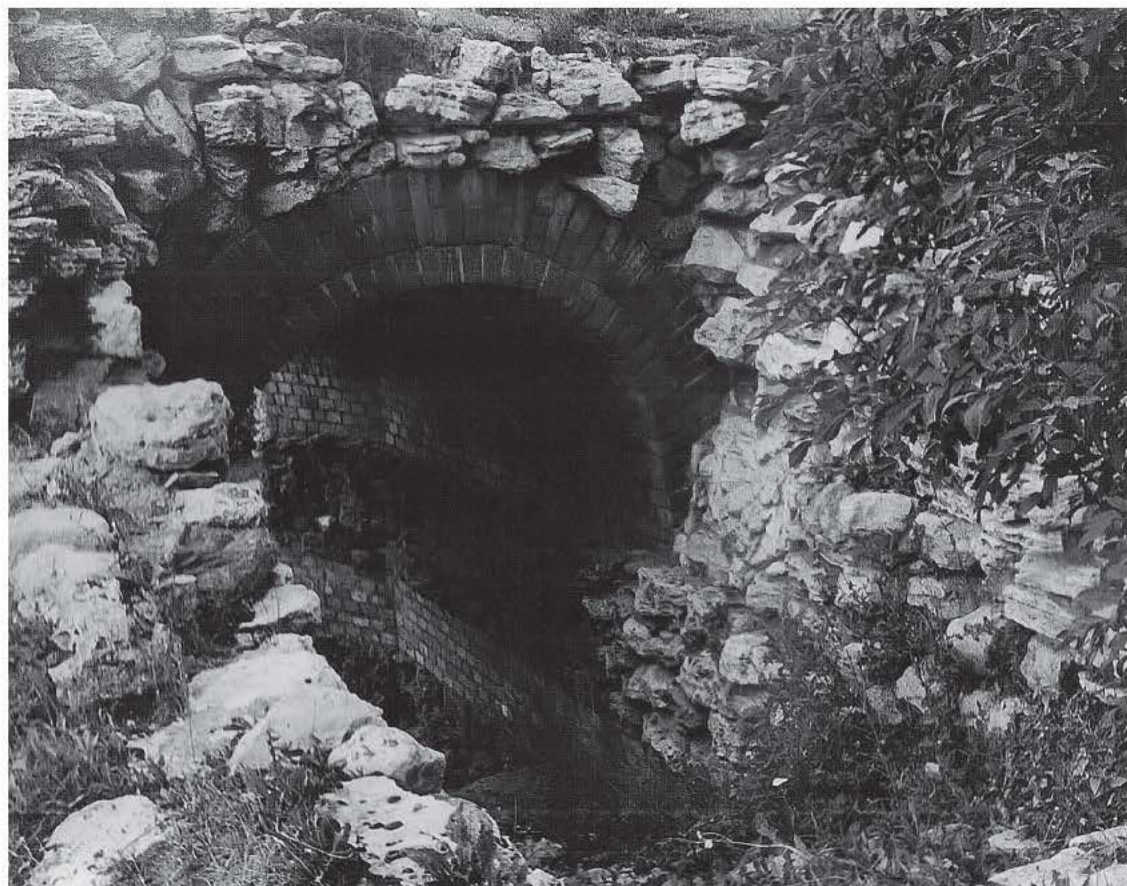
↑ Фрагмент циклопической кладки Грота до реставрации
