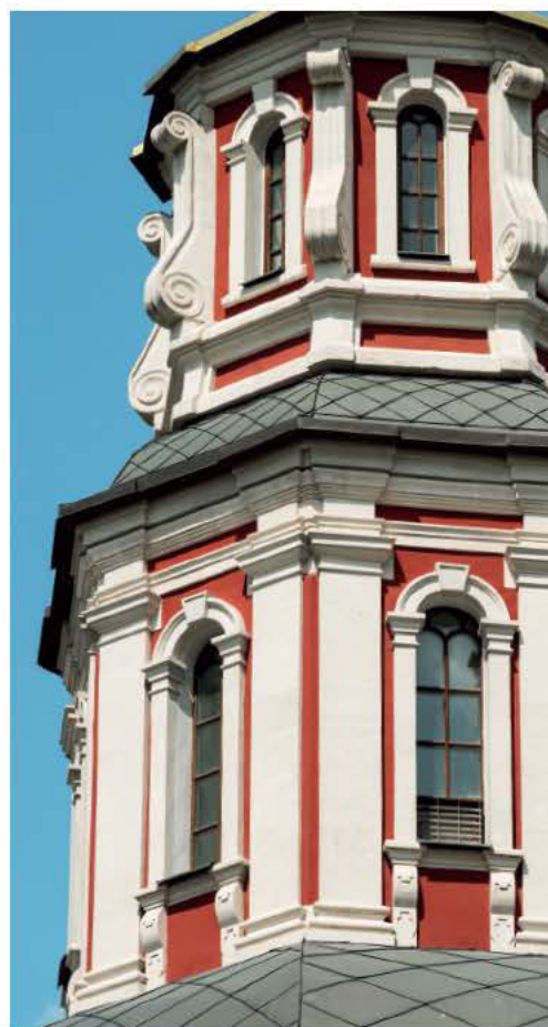
↑ Восстановленные элементы двухъярусного завершения храма
