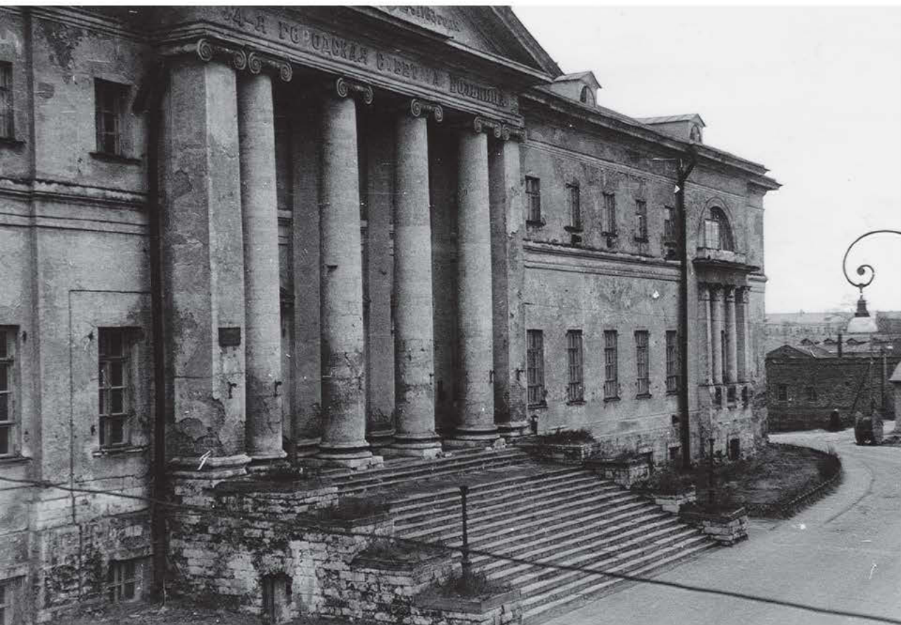
↑ Общий вид главного (западного) фасада главного корпуса до реставрации
