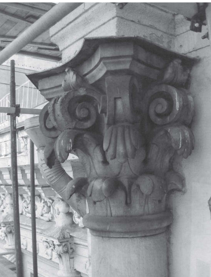
↑ Капитель колонны колокольни в процессе реставрации
