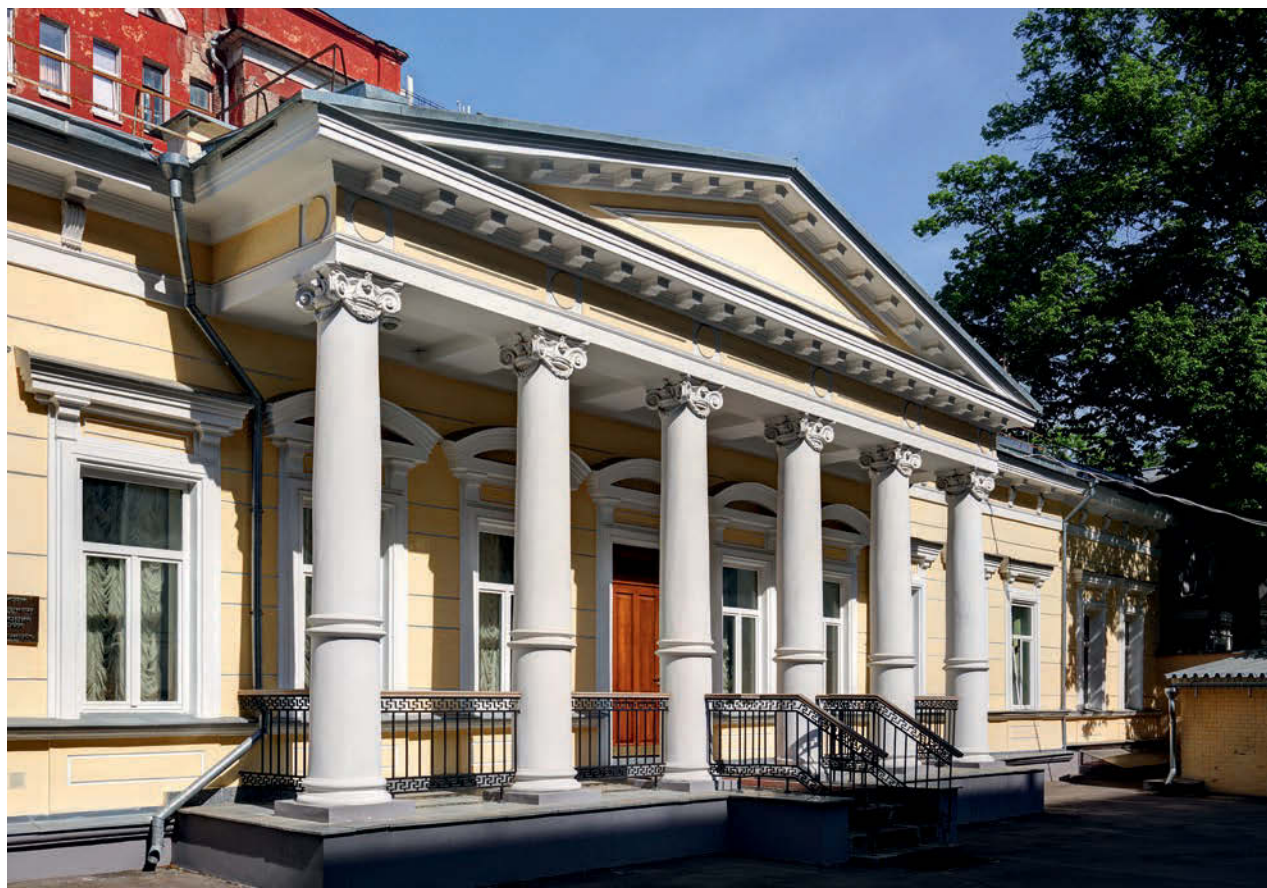
↑ Главный фасад дома после реставрации
