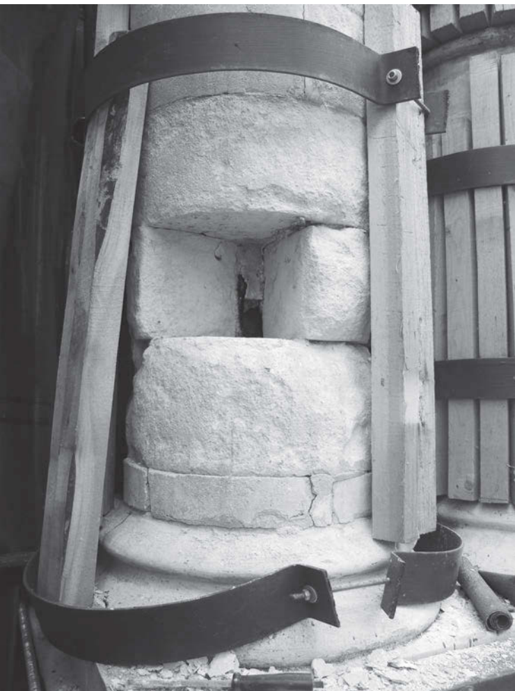
↑ Реставрация белокаменной колонны
