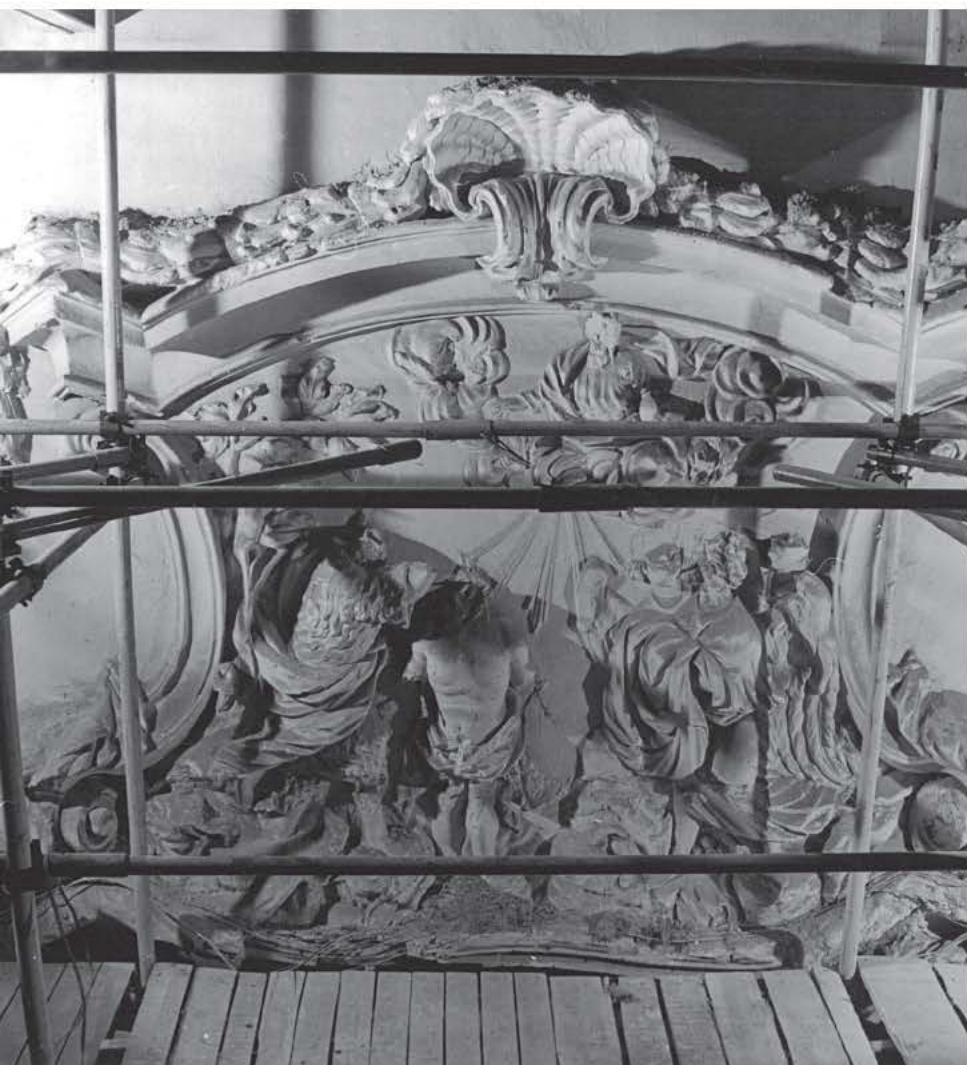
↑ Состояние лепной композиции верхнего храма после снятия позднего перекрытия
