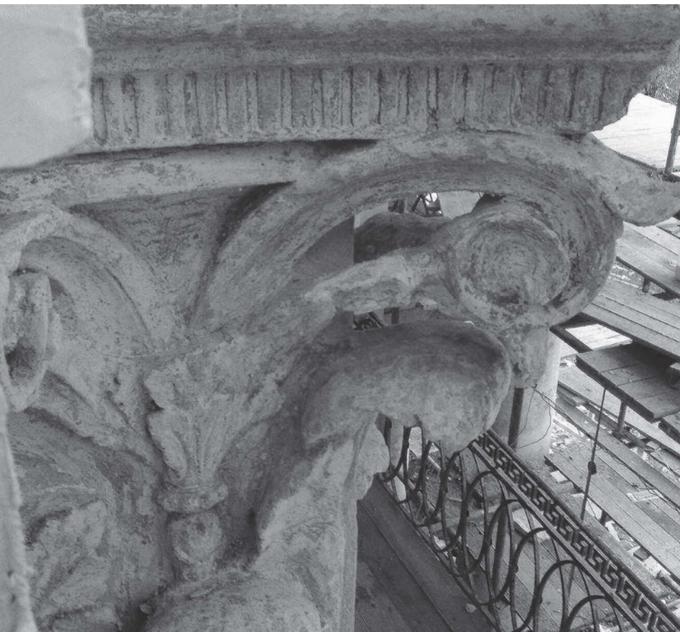
↑ Реставрация лепных элементов капители белокаменного портика
