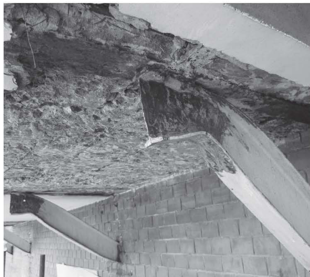
↑ Фрагмент главного балкона в процессе реставрации
