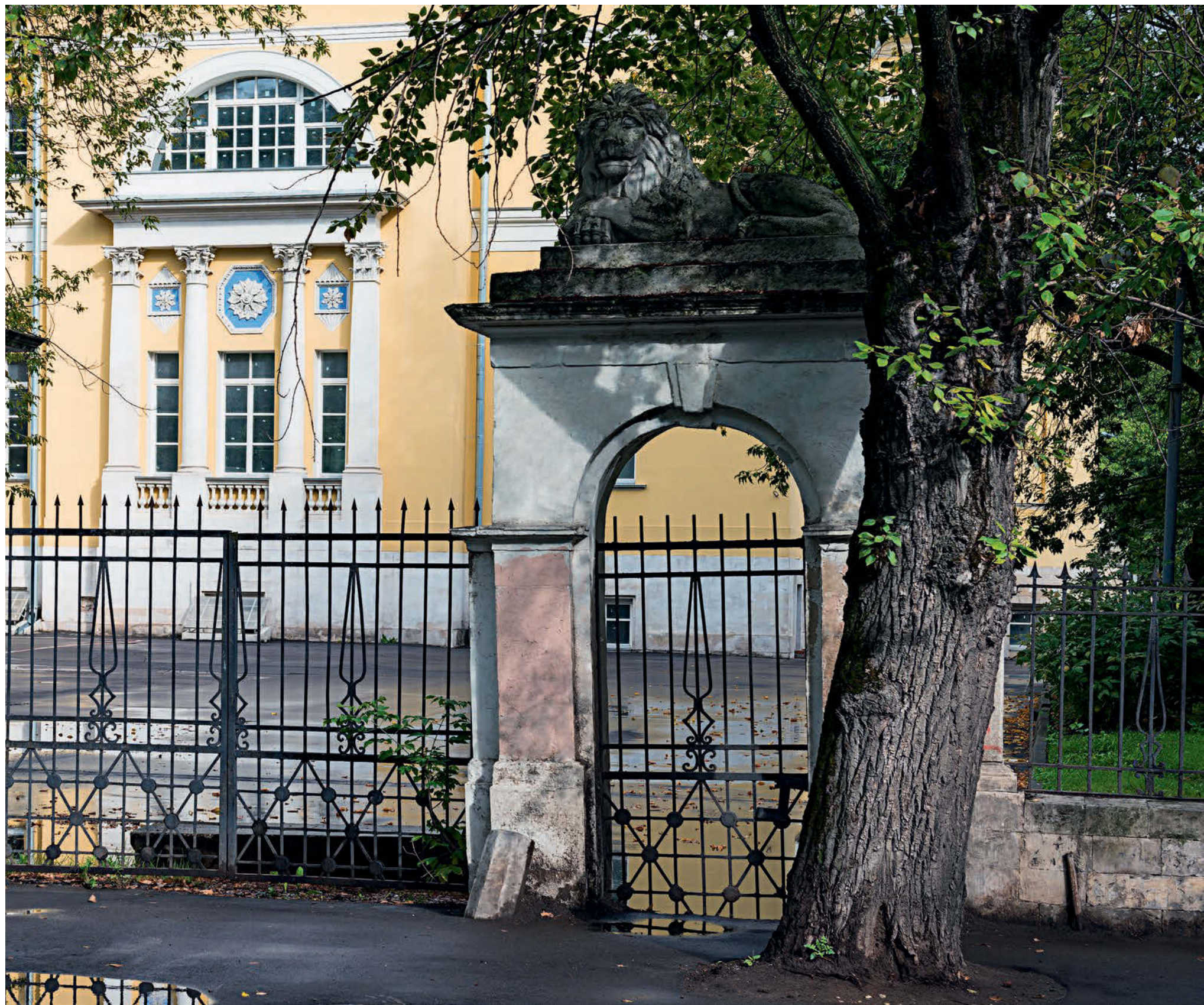
↑ Пилон ворот ограды по улице Павловской после реставрации
