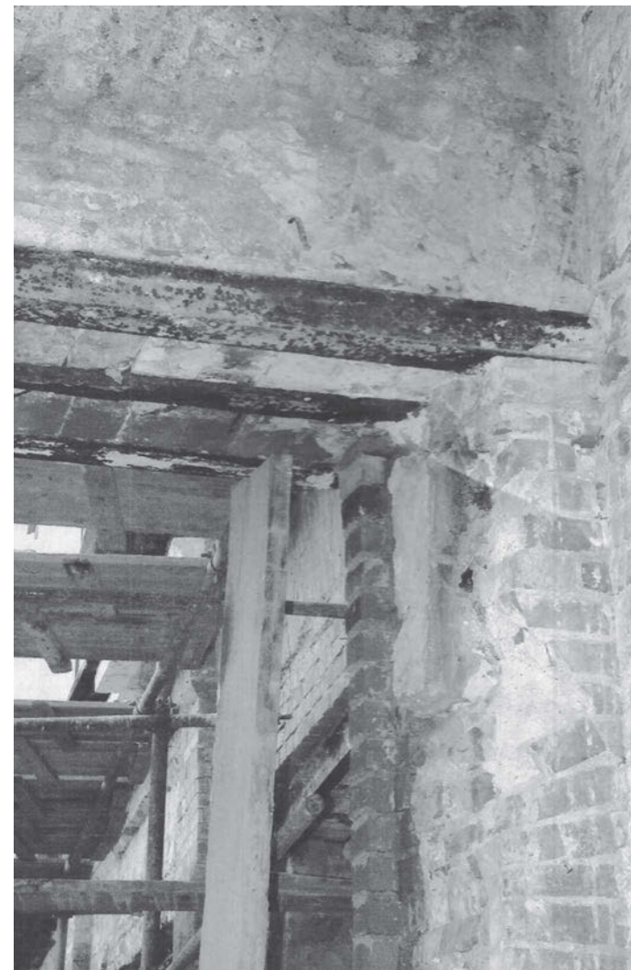
↑ Состояние кирпичных стен до реставрации
