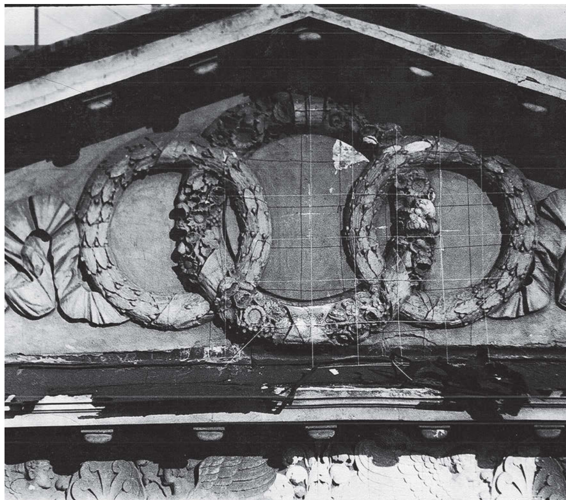
↑ Фрагмент фронтона портика главного фасада до реставрации
