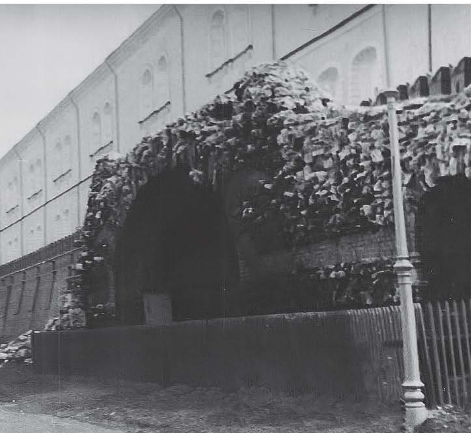
↑ Общий вид Грота до реставрации
