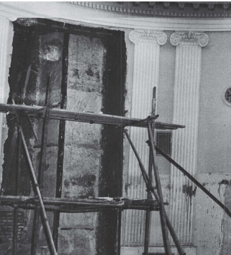
↑ Пилястры декора ионического ордера стен Овального зала в процессе реставрации
