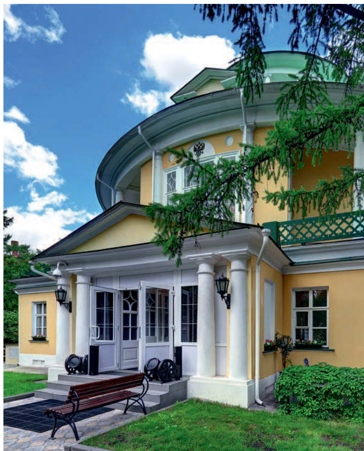
↑ Западный фасад после реставрации
