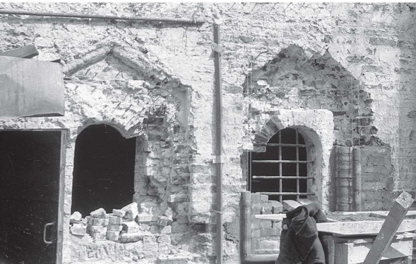
↑ Фрагмент северного фасада в процессе реставрации
