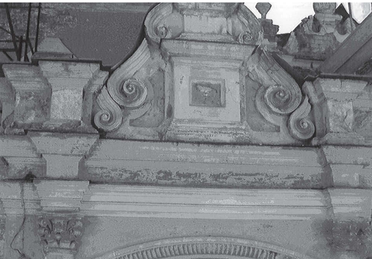
↑ Фрагмент фасада до реставрации
