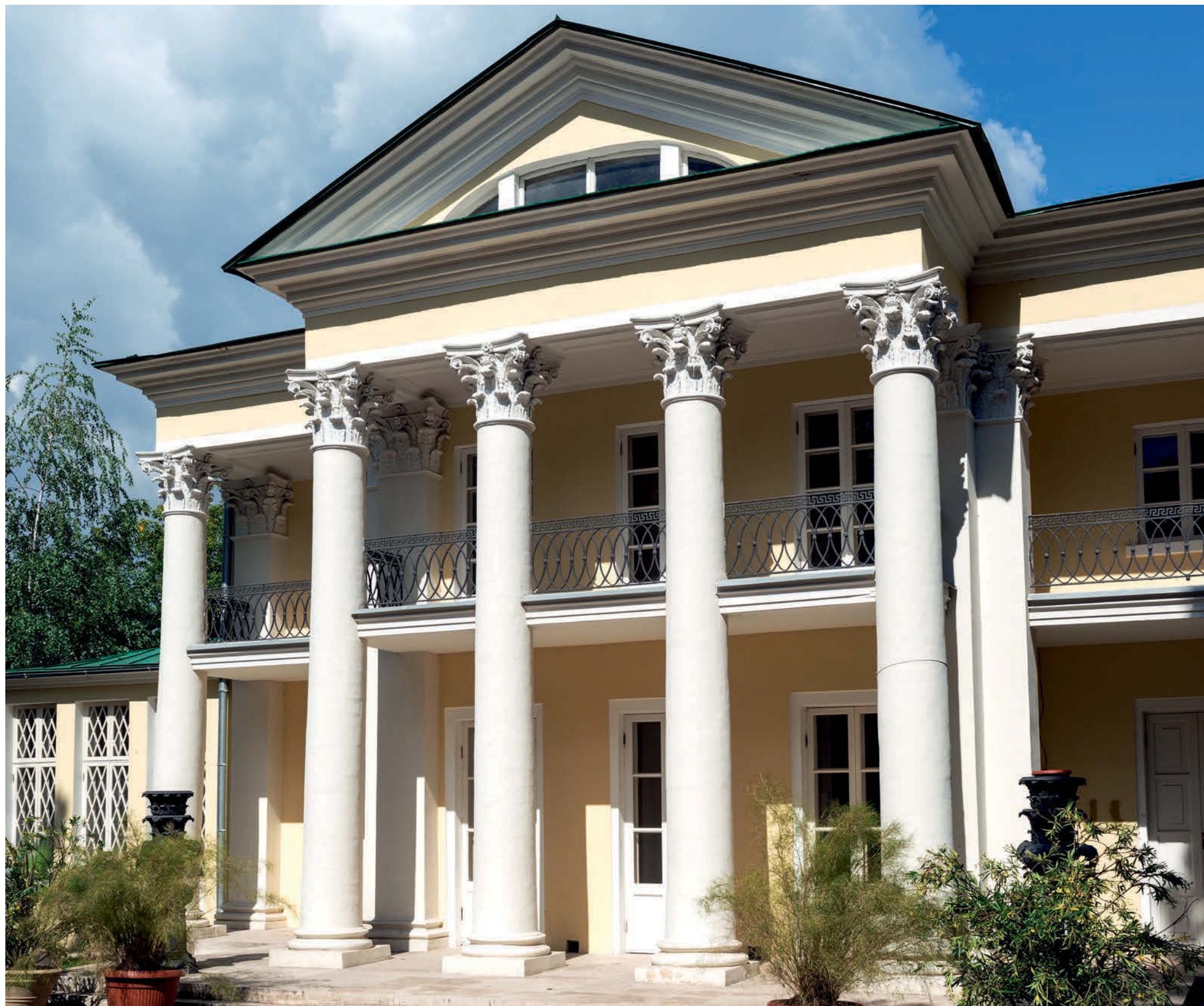
↑ Общий вид Летнего домика после реставрации. Отреставрированный белокаменный коринфский портик и восстановленные балконы
