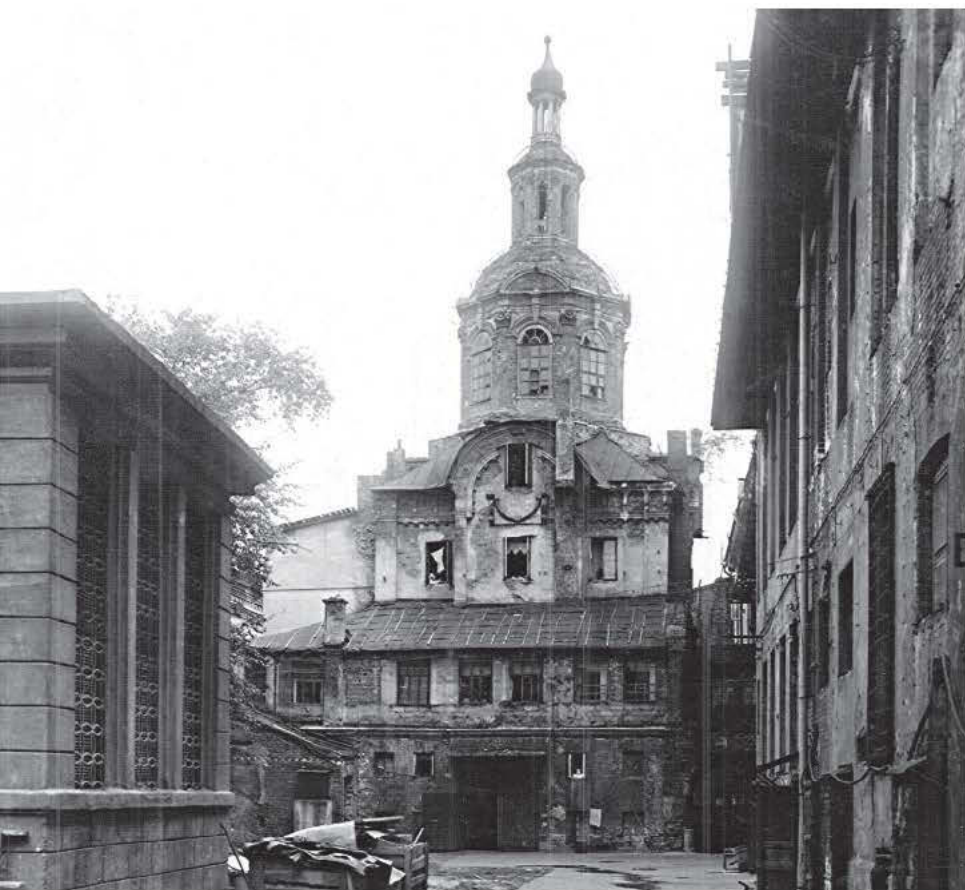
↑ Главный (западный) фасад собора до реставрации
