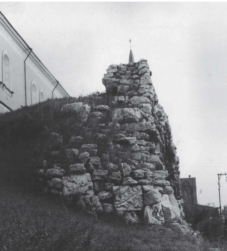
↑ Северный фасад Грота до реставрации
