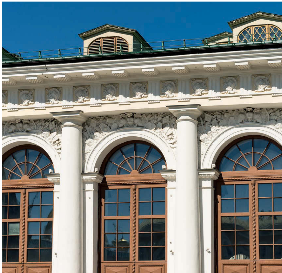
↑ Фрагмент входа на боковом (восточном) фасаде после реставрации
