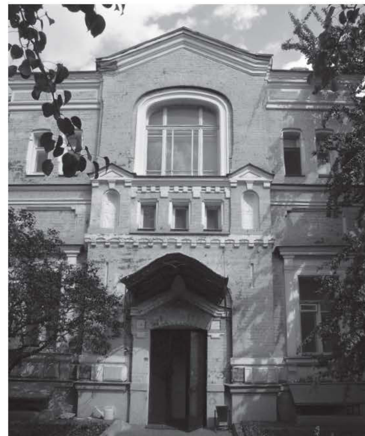
↑ Фрагмент дворового фасада (юго-восточного) до реставрации
