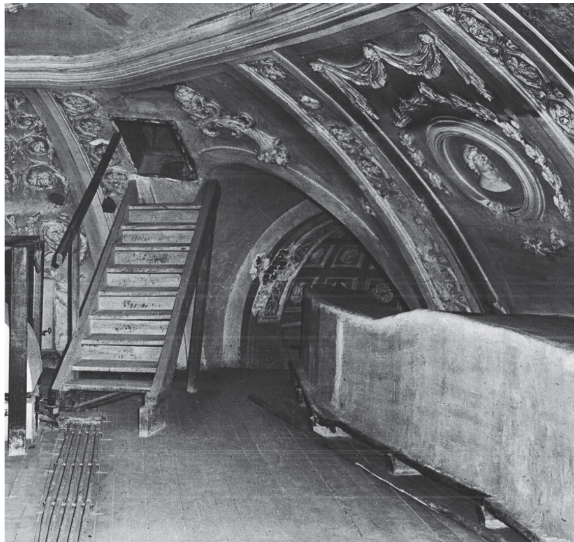
↑ Фрагмент сводчатого потолка Овального зала на чердаке до разборки перекрытий над залом
