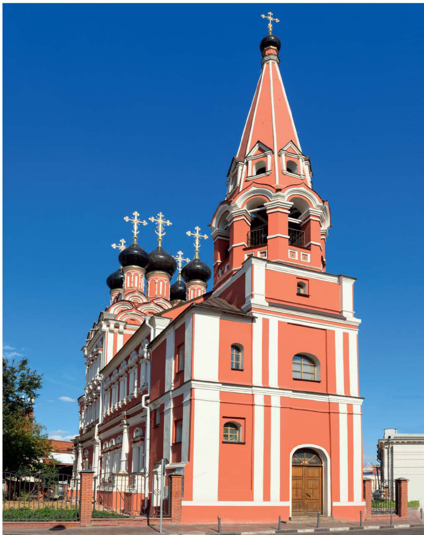
↑ Общий вид памятника после реставрации, западный фасад
