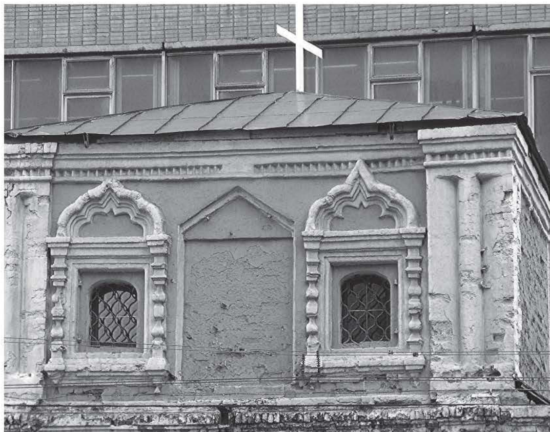
↑ Вид второго яруса колокольни до реставрации
