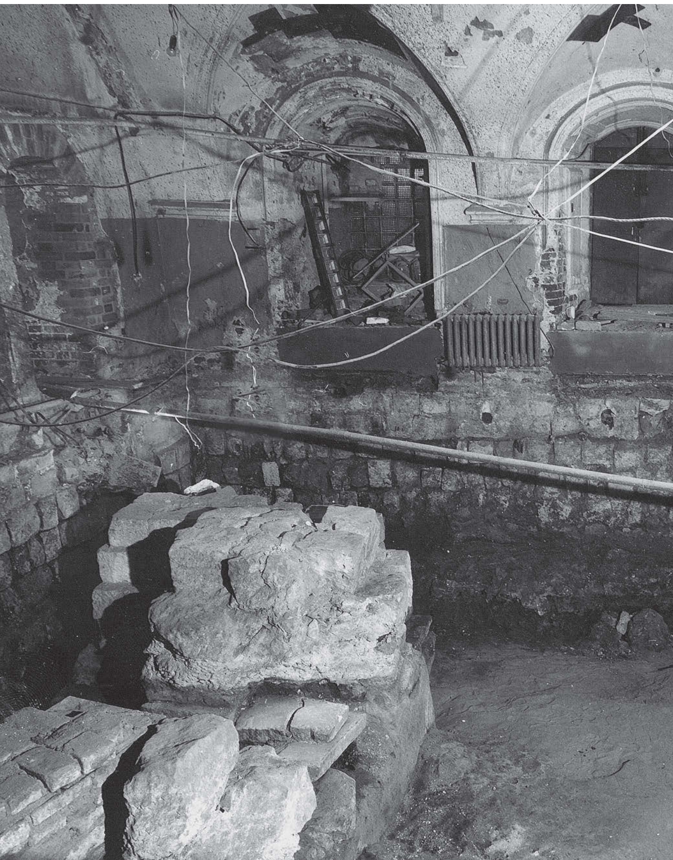
↑ Общий вид четверика нижнего храма XVII века до реставрации. Под засыпкой пола были обнаружены белокаменные элементы — опорные столбы храма конца XIV — начала XV века
