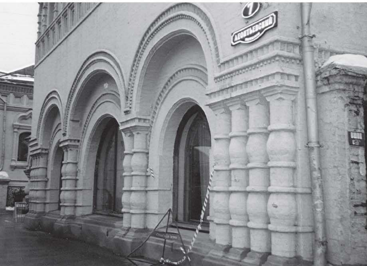
↑ Главный фасад до реставрации
