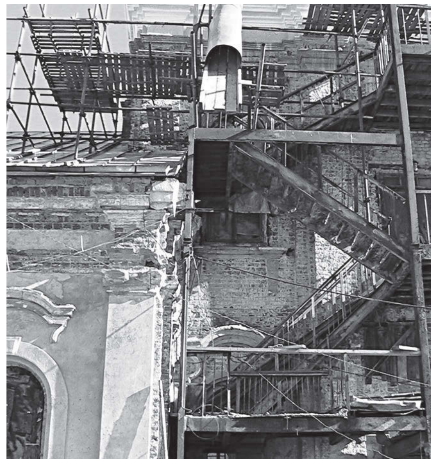
↑ Фрагмент фасада во время реставрации
