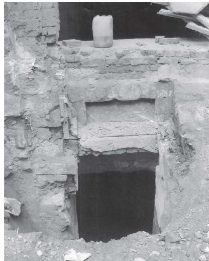
↑ Оконные проемы первого этажа в процессе раскрытия
