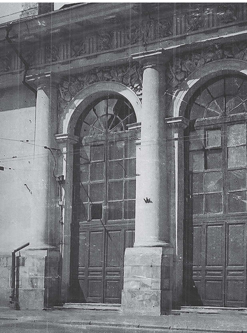
↑ Фрагмент входа на боковом (восточном) фасаде до реставрации
