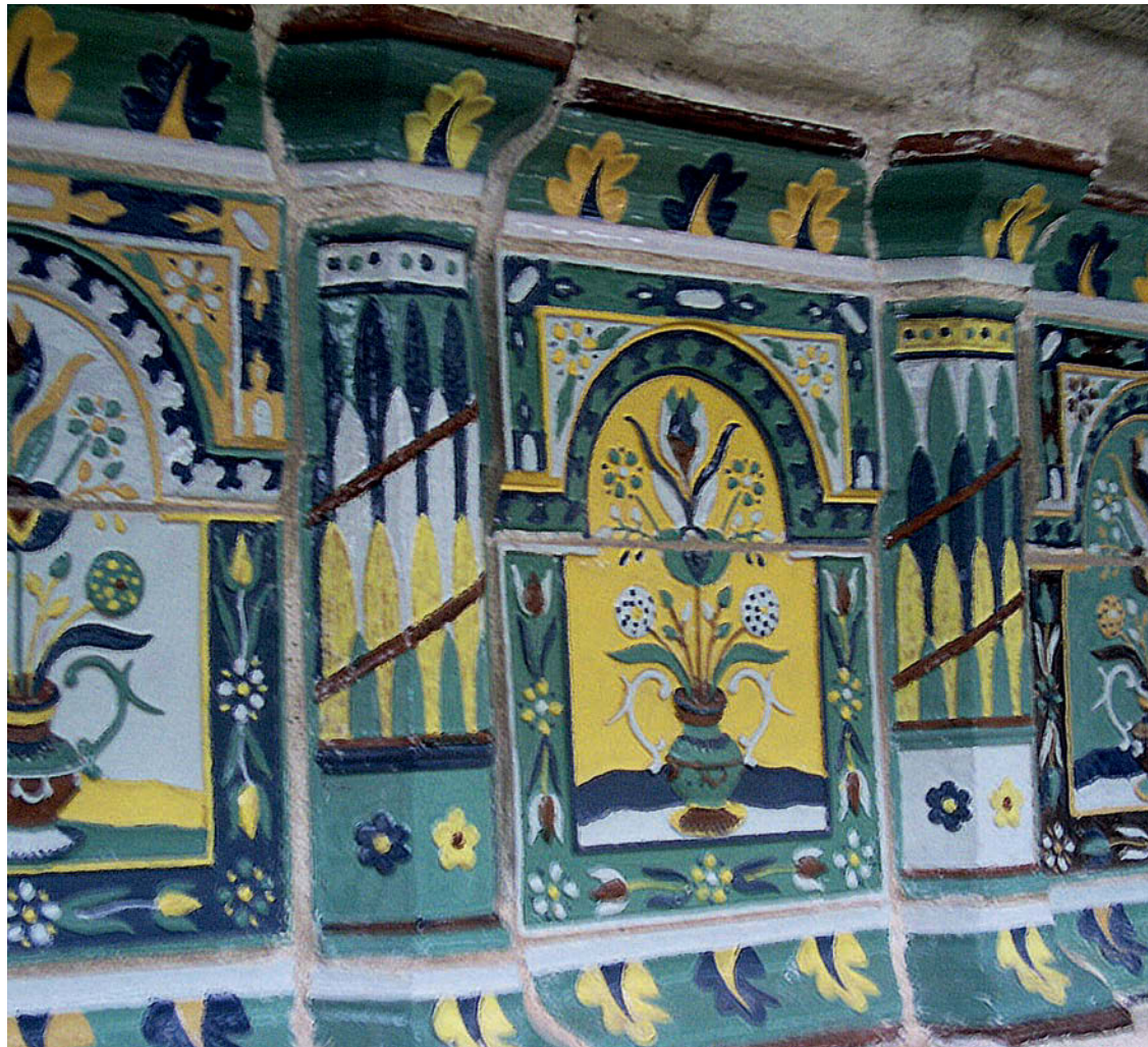
↑ Восстановленный декоративный фриз первого яруса, отреставрированы и докомпонованы полихромные изразцы — кахели
