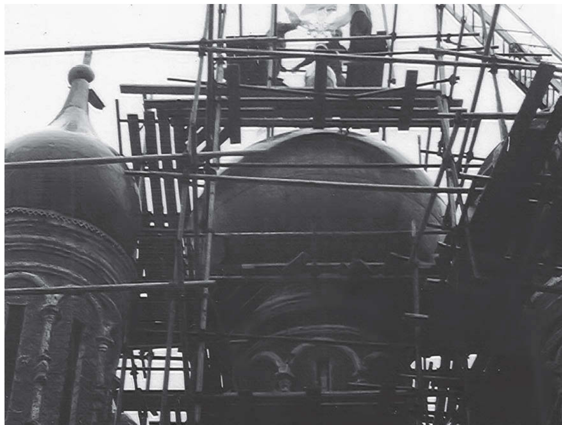
↑ Реставрационные работы с укреплением подкрестного яблока центральной главы для последующей установки креста
