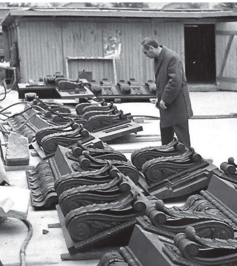
↑ Детали карниза арки, подготовленные для монтажа
