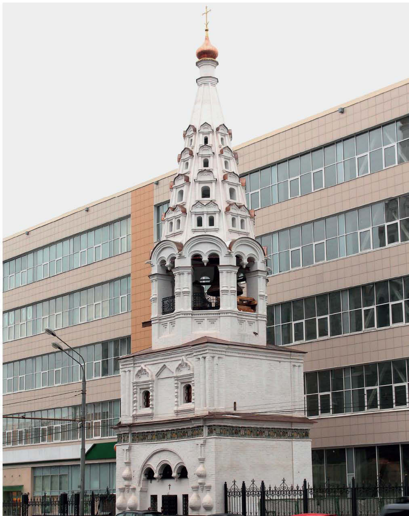
↑ Общий вид колокольни после реставрационных работ и воссоздания утраченного яруса звона и шатра
